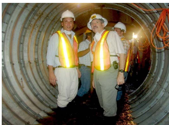
Figura No. 2-9: Alcantarillado Pluvial-Isla Trinitaria
