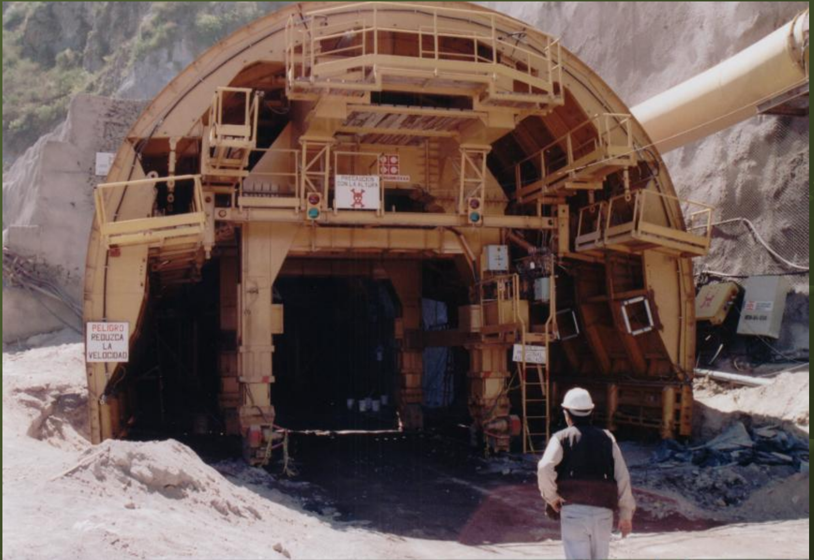
Encofrado Metálico para el Túnel de Quito
