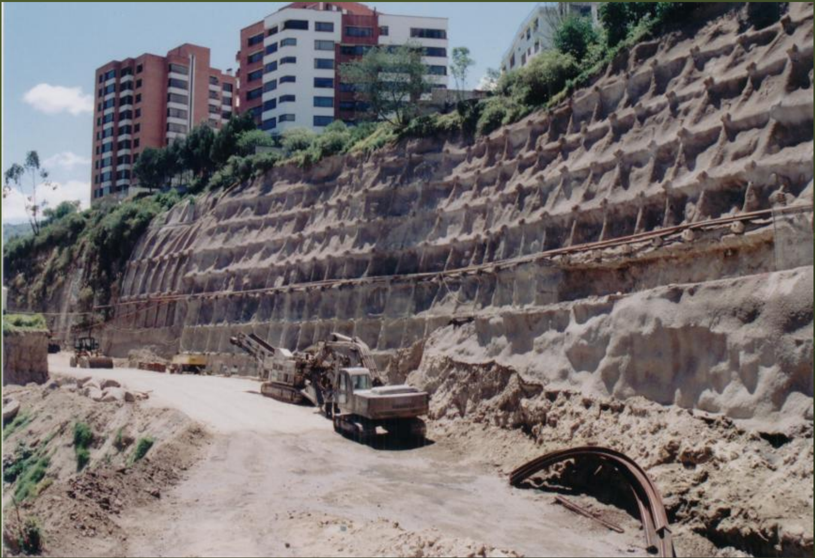
Pernos de anclaje para sostenimiento del talud
