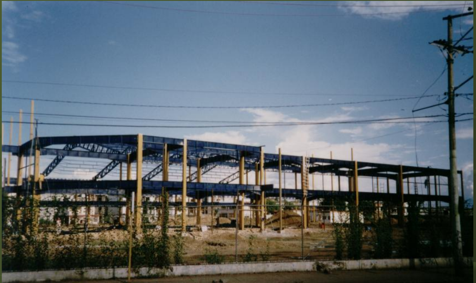
Estructura metálica del comisariato Santa Isabel-Guayaquil
