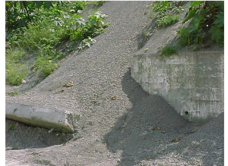
**Obras de ingeniería que han fallado para detener los deslizamientos y han sido sepultadas por los mismos. Estas obras se continúan construyéndose a pesar de que no funcionan.**
