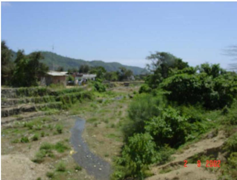
**Agresivo proceso de sedimentación, producto de la erosión y deslizamientos de las partes altas. Se evidencia que la obra de ingeniería con los gaviones no detuvo este proceso y constituye un gasto innecesario**
