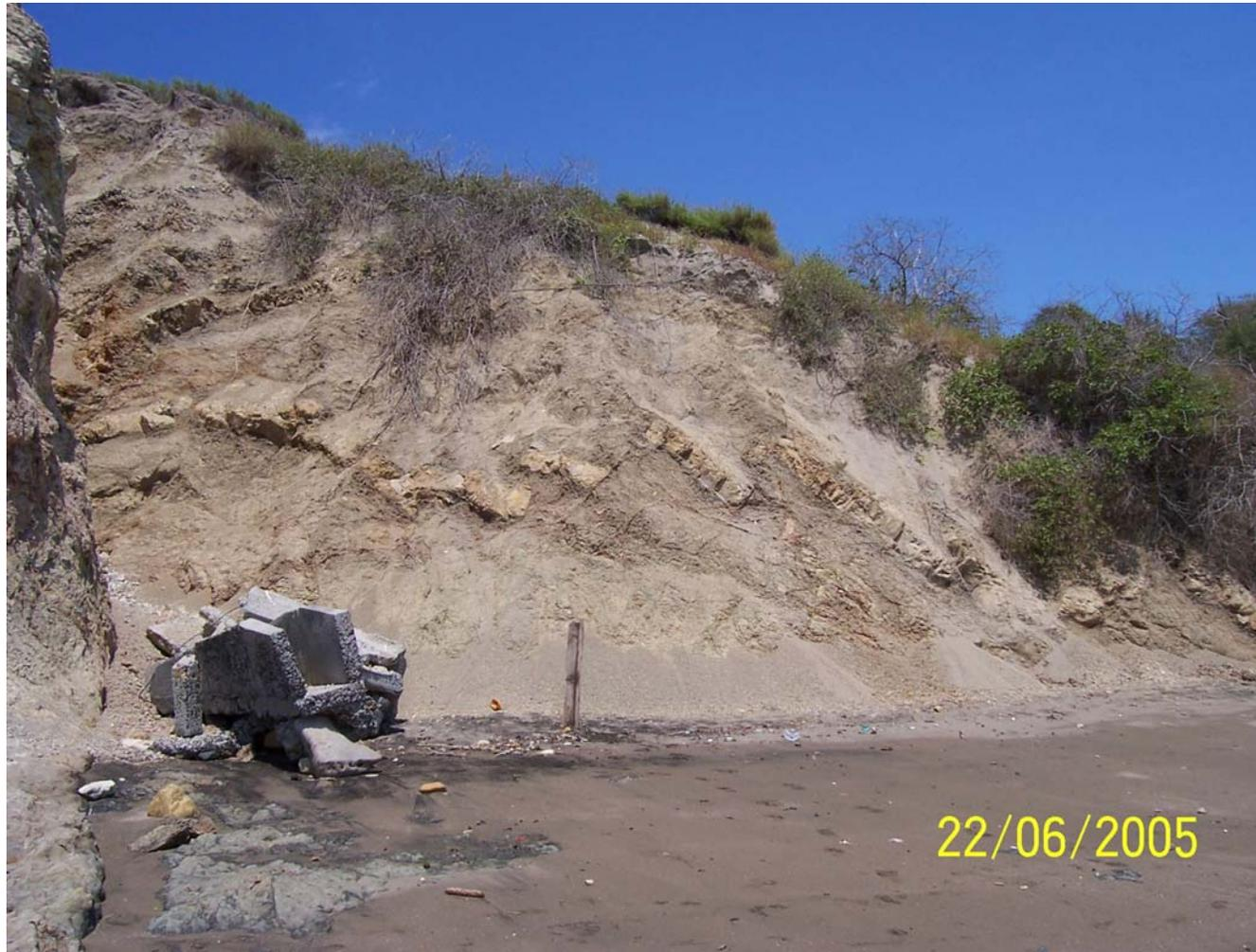
**TALUD FRENTE AL MAR: Se aprecia cuñas de roca debido a la estratificación, a los juegos de fracturas y al talud**
