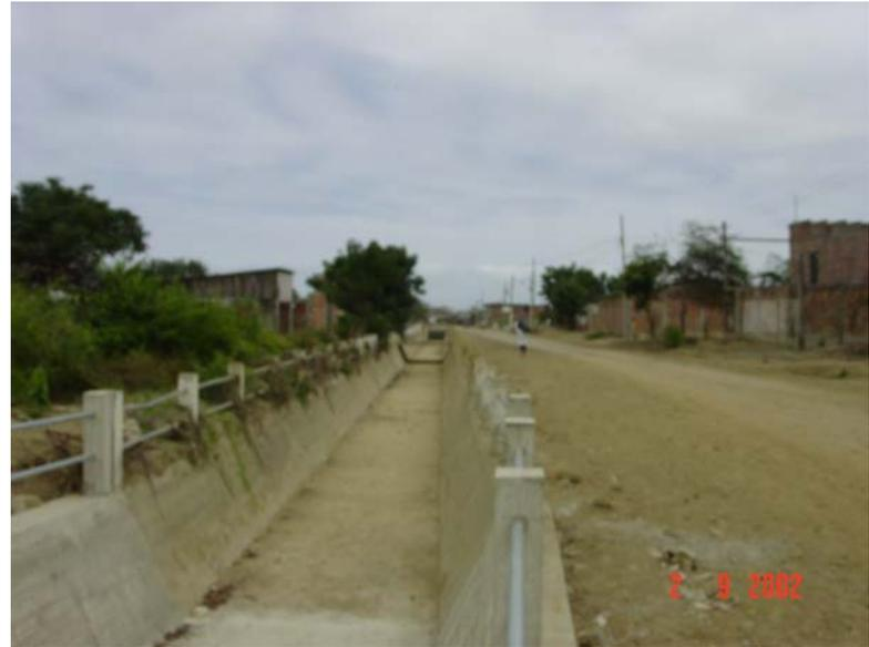
**Famoso canal que debería encauzar los sedimentos y flujos, pero que como se aprecia se está solvatando poco a poco y no soluciona el problema**
