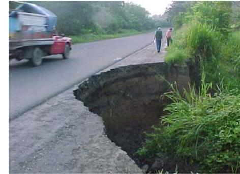
**Se evidencia el tipo de material muy blando y el proceso de erosión, arrastre y deposición de sedimentos que sufre**
