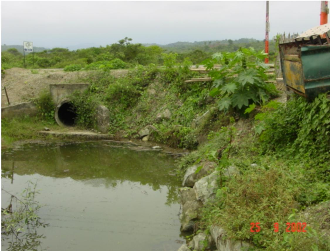
**Malas obras de ingeniería que no abastecen las necesidad del caudal por lo que provoca acumulación del fluido lo que a su vez ocasiona erosión, arrastre y depositación aguas debajo de los sedimentos**
