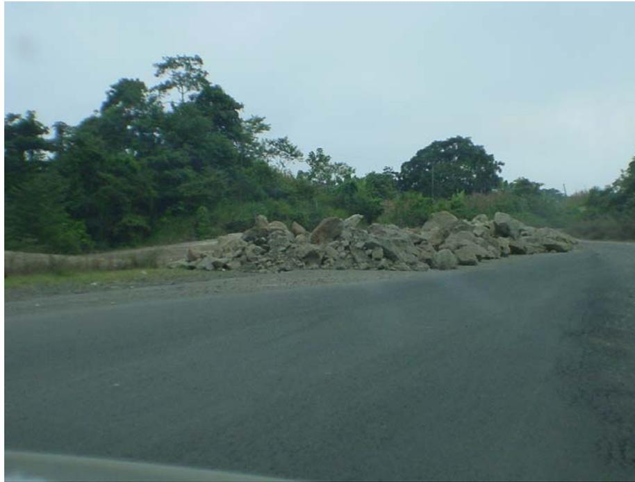
**Típica obra de mala ingeniería, donde se coloca material extremadamente pesado sobre la cabecera de una quebrada, que después termina en un deslizamiento traslacional**
