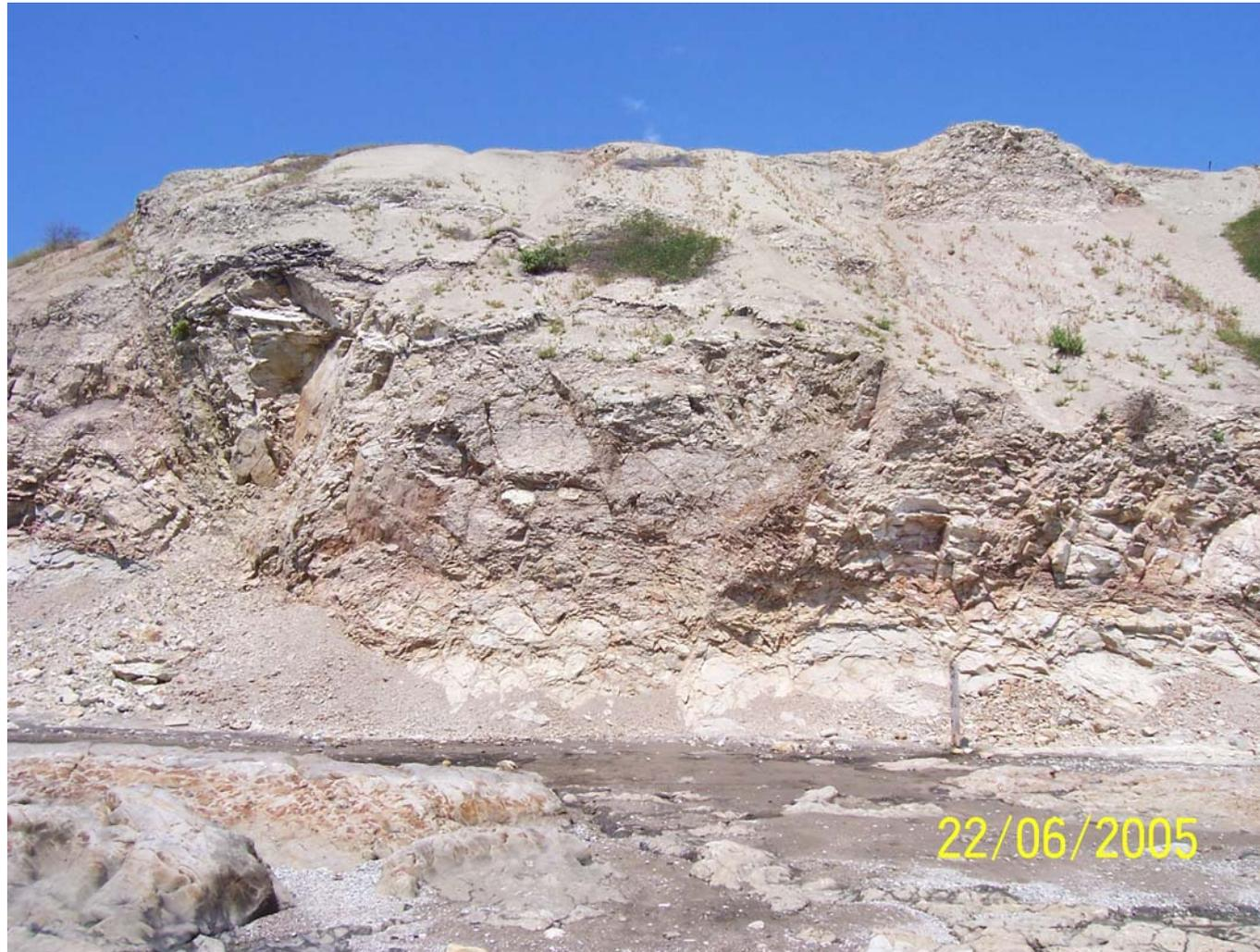
**TALUD FRENTE AL MAR: Se observa las capas de material arrojado con maquinaria sobre el talud.**
