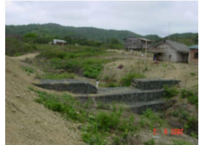
**Obras de ingeniería no sustentables e imprácticas: colocaron muros de gaviones para detener el flujo de sedimentos, se produjo depositación masiva y ahora estos muros están cubiertos por los mismos sedimentos que se supone iban a detener**
