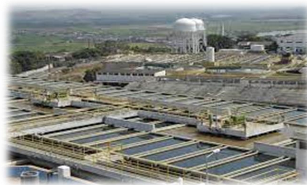
Figura 7 Plantas de Tratamiento de Agua Potable en los que se dosifican químicos para su tratamiento
