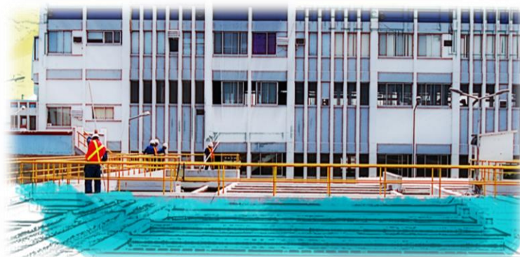
Figura 9 Edificio estructural de la Estación de Bombeo de agua cruda “La Toma”
