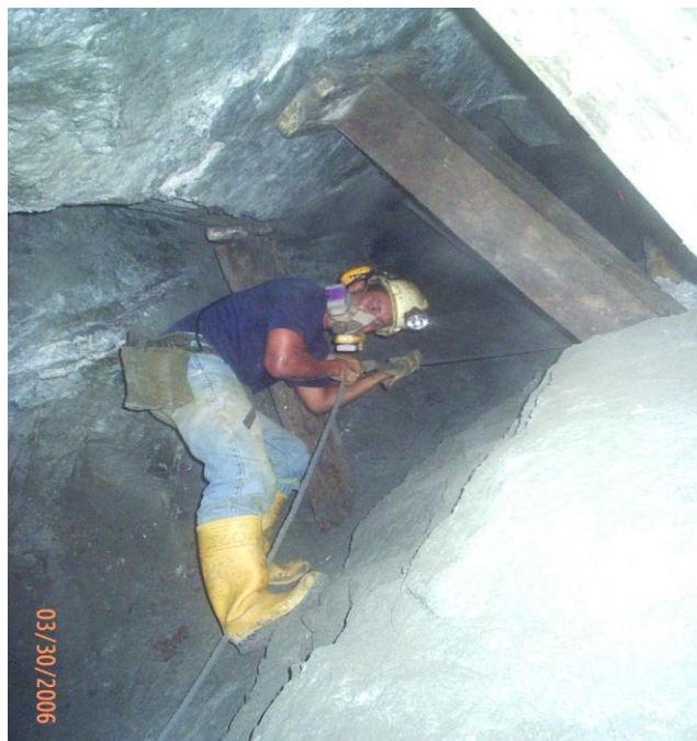
Fig. 22. Reemplazo de un pilar mineralizado por sostenimiento de madera ( Crespo J. 2007)
