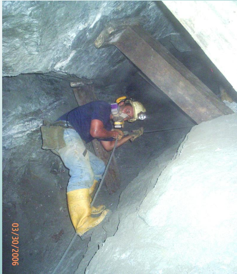
Reemplazo de un pilar mineralizado por sostenimiento de madera ( Crespo J. 2007)
