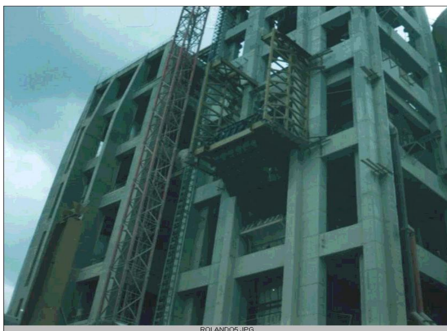
FIGURA 4.2. MONTAJE DE DUCTO EXTERIOR DEL CALCINADOR
