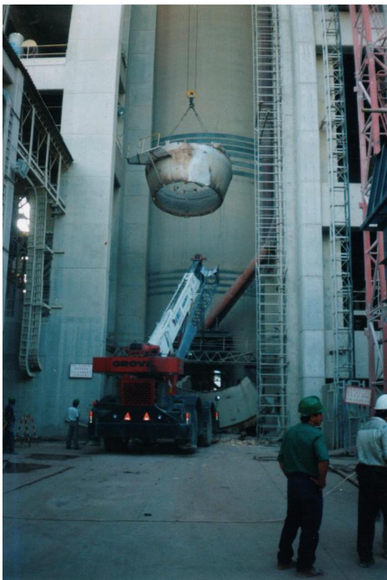
FIGURA 4.1. DESMONTAJE DE SECCION CONICA DE CICLON
