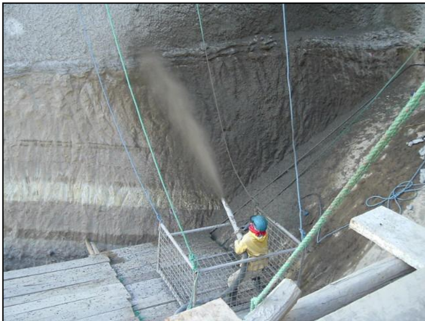
FOTO 12. ESTABILIZACIÓN DE PAREDES MEDIANTE GUNITADO
