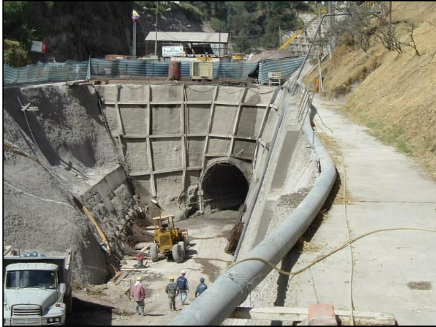
FOTO 5. ACCESO AL ACUEDUCTO SANITARIO (QUITO)
