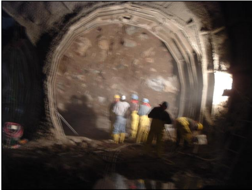
FOTO 11. INTERIOR DEL ACUEDUCTO SANITARIO
