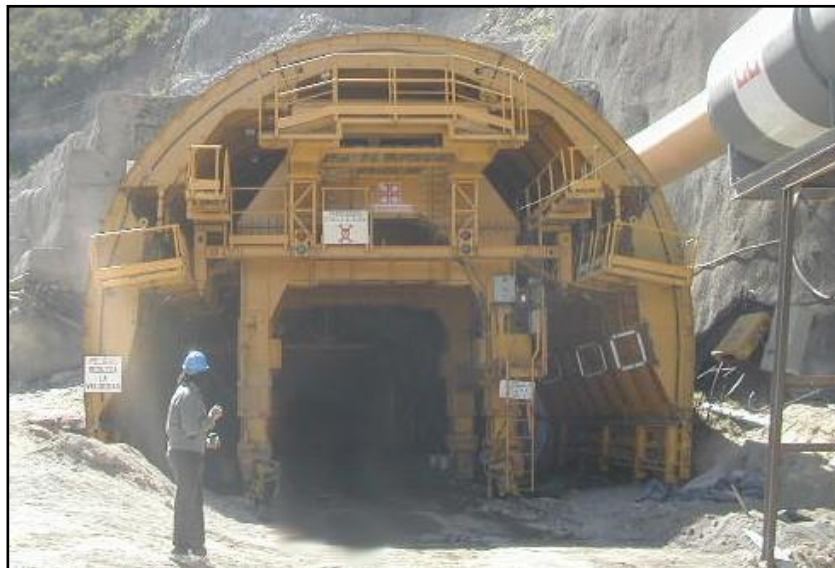
FOTO 10. SISTEMA DE ENCOFRADO METALICO Y VIBRADOR DE PARED
