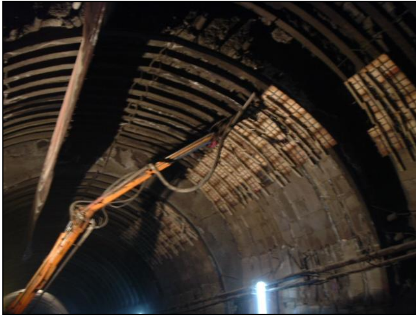
FOTO 9. GUNITADO DE PAREDES DEL TUNEL VIAL
