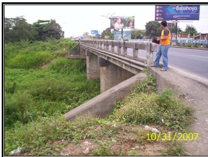
Foto 1.6 Vista aguas arriba de apoyos.
