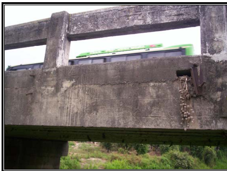
Foto 1.7 Vista lateral del tablero.
