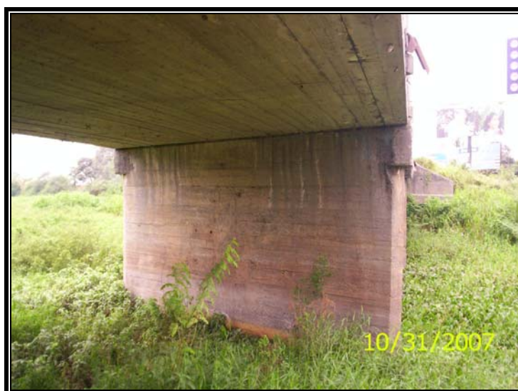
Foto 1.4 Vista de tablero y pila.
