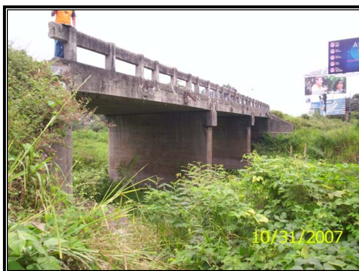
Foto 1.3 Vista aguas abajo de apoyos.
