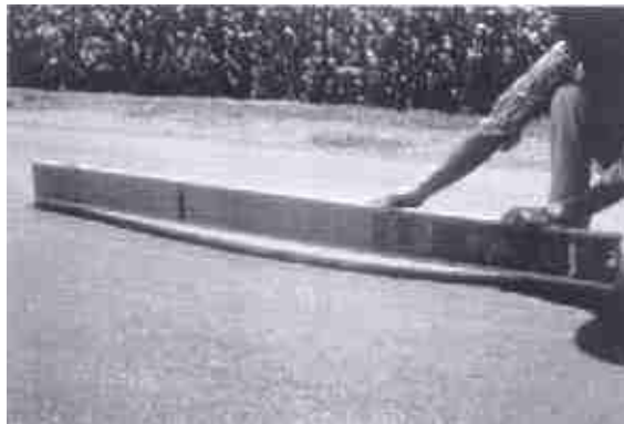
FOTO No. 4.18.- Falla Depresión – Severidad Alta
