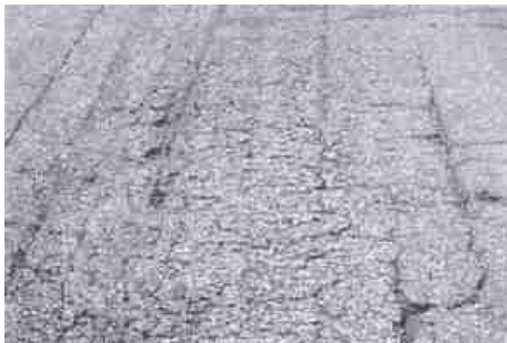
FOTO No. 4.53.- Falla Intemperismo – Severidad Alta
