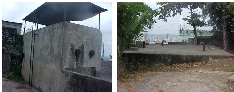
Foto 1 Izq.- TANQUE ELEVADO SIN LOSA SUPERIOR 10 M 3 , Der.-CISTERNA ALTA 160 M 3
