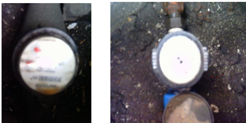
Foto 18 Medidores pertenecientes al Canal 5 "TELEAMAZONASTV".
