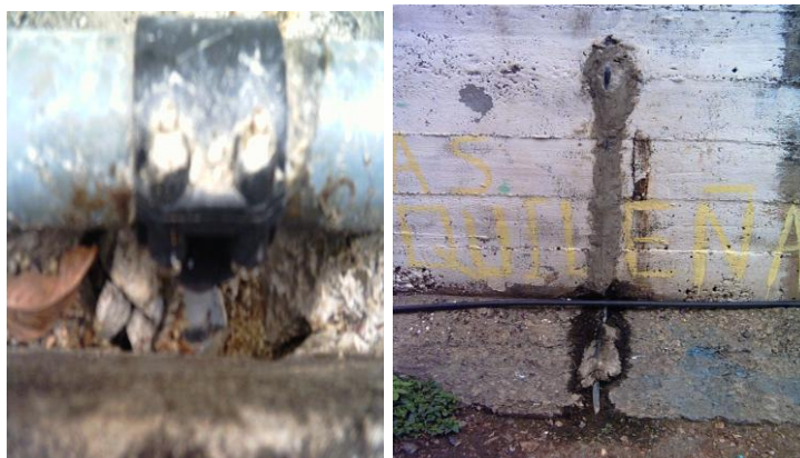
Figura 15. Conexión clandestina de 2", que alimentan a 6 familias.
