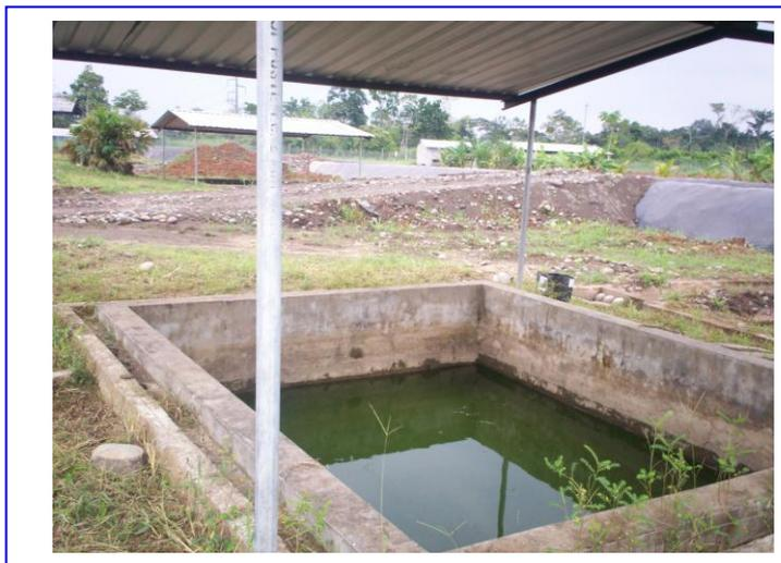
Fig.3.21 Piscina de cemento receptora de lixiviados provenientes de la Unidad de Landfarming.; tomada en el Cañón de los Monos-Coca, Cristina Ballesteros, febrero del 2007.
