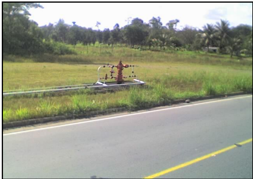
Figura 4.12 Locación pozo SACHA-09
