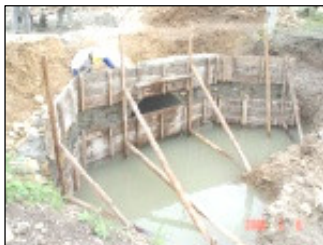
Figura 11. Colocación de Encofrados en Muros de Alas
