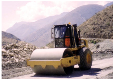
Figura 10. Rodillo compactando Capa a Nivel de Subrasante
