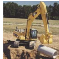
Figura 8. Izado de Tubería
