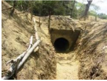
Figura 14. Alcantarilla luego de la limpieza
