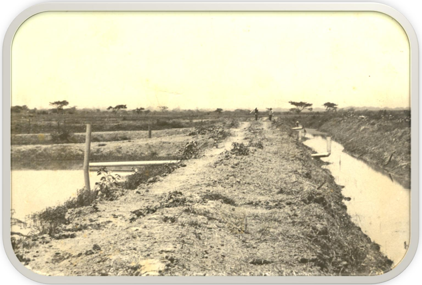
Vista parcial de los estanques de la estación.
