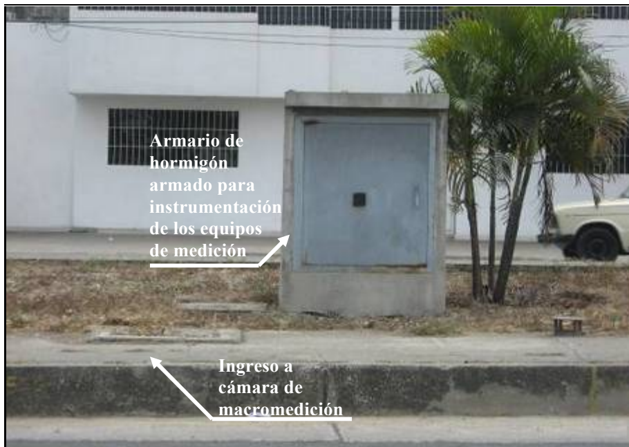
Fotografía 5. Armario de hormigón armado que alberga la instrumentación de los equipos de medición y cámara de macromedición del punto FNC-CTP-M34 ubicado en la Av. Barcelona (Fuente: Departamento de Modelación y S.I.G., Subgerencia de Agua Potable, Interagua C. Ltda.)
