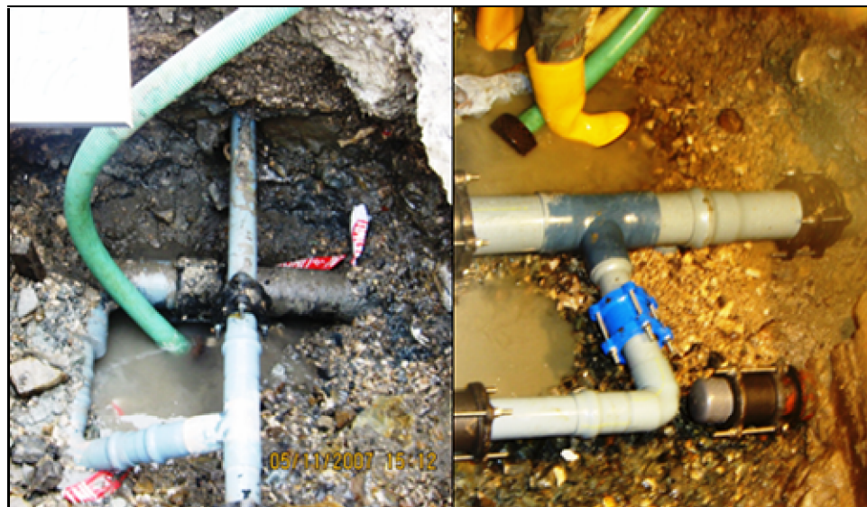
Fotografías 3 y 4. Empate (izquierda) y taponamiento (derecha) ejecutados para adaptar la red de distribución de AA.PP. a los límites de la sectorización hidráulica (Fuente: Departamento de Sectorización, Subgerencia de Agua No Contabilizada, Interagua C. Ltda.)
