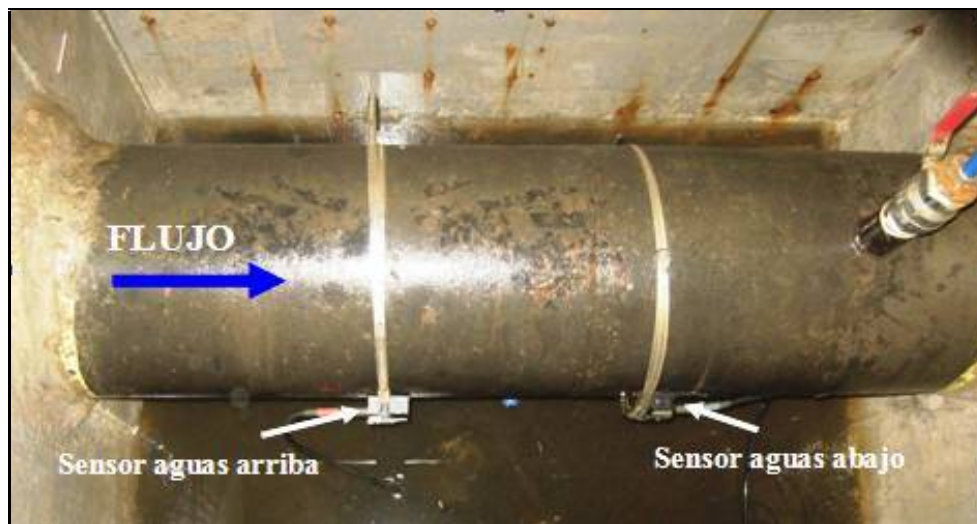
Fotografía 11. Instalación de sensores tipo "clamp-on" sobre una tubería de 350mm AC según método de instalación en "V", para un caudalímetro ultrasónico Polysonics DCT6088 (Thermo). Punto de macromedición CTP-064-M40 ubicado en calle 38 y R. Avilés.
