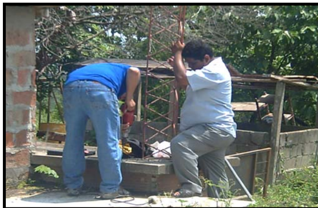
Fig 4.1 Colocación de la Torre
