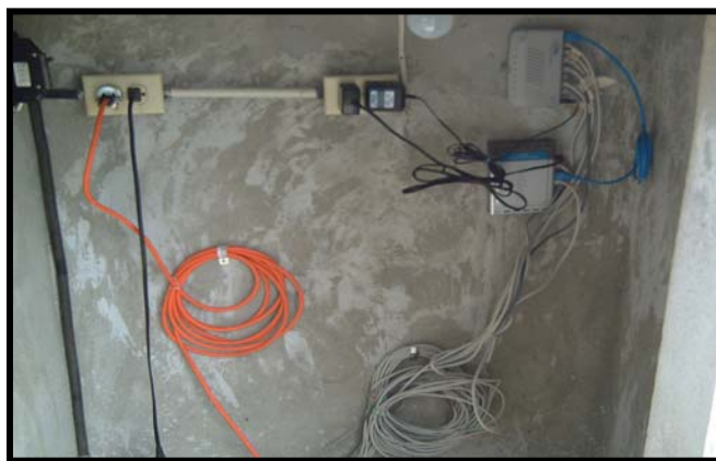
Fig 4.2 Equipos dentro de la Cabina
