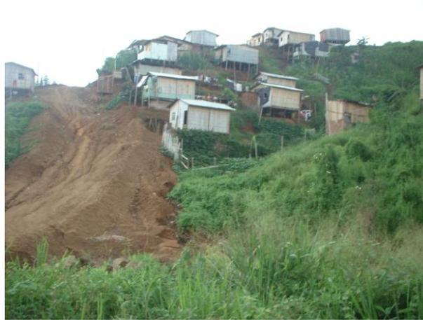
**Foto 1.3** Balerio Estacio, construcciones levantadas en sectores con talud > 30%, no recomendables para ser habitadas.
