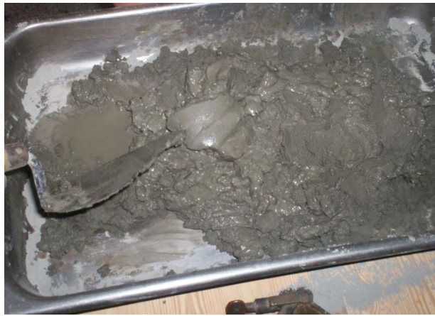
FIGURA 3.19. OBTENCIÓN DE LA PASTA DE CEMENTO COMPUESTO.
