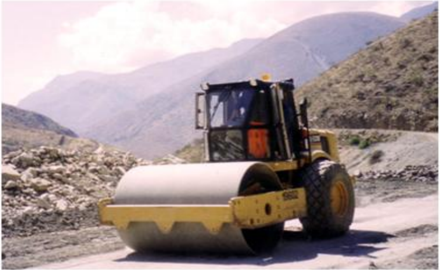
Figura 3.18 Rodillo compactando Capa a Nivel de Subrasante
