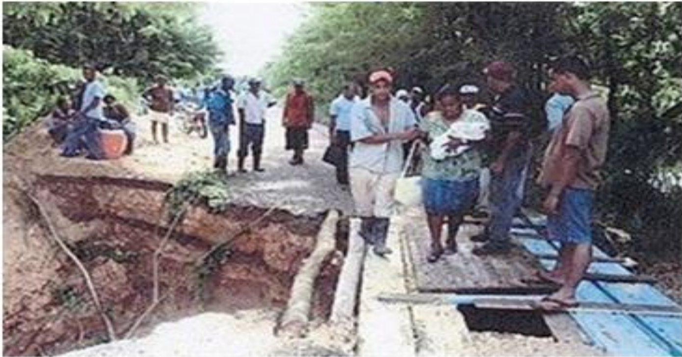
Figura 4.1 Consecuencias de no llevar un mantenimiento
