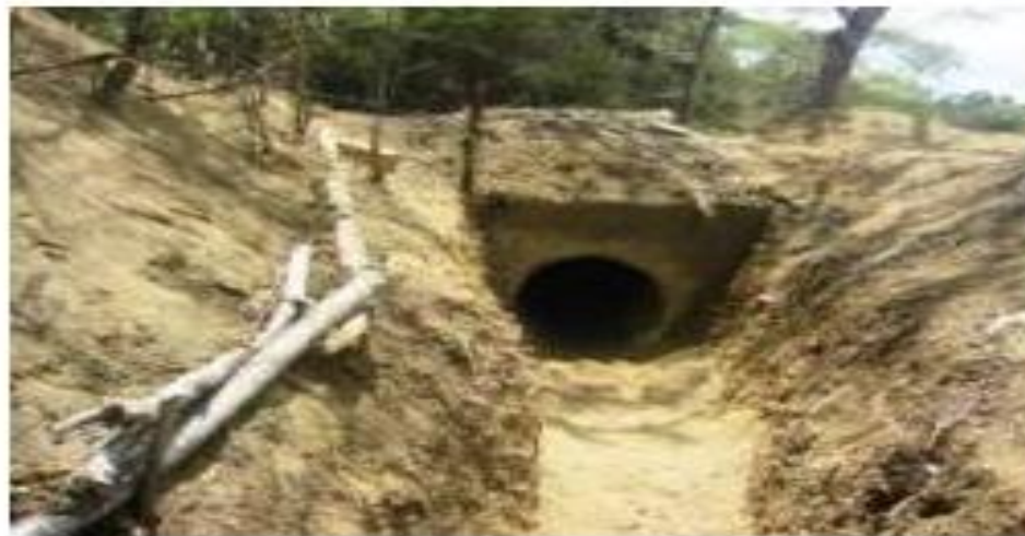
Figura 4.4 Alcantarilla luego de la limpieza
