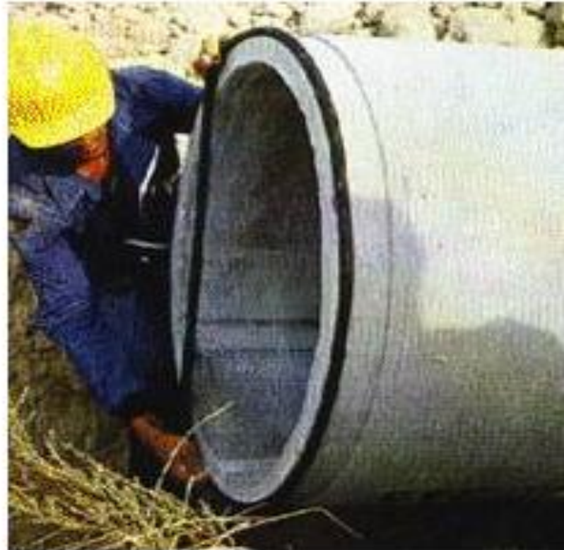
Figura 3.10 Instalación de juntas de neopreno
