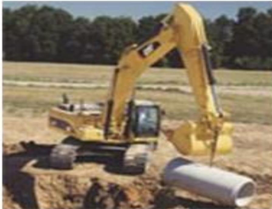
Figura 3.5 Izado de Tubería
