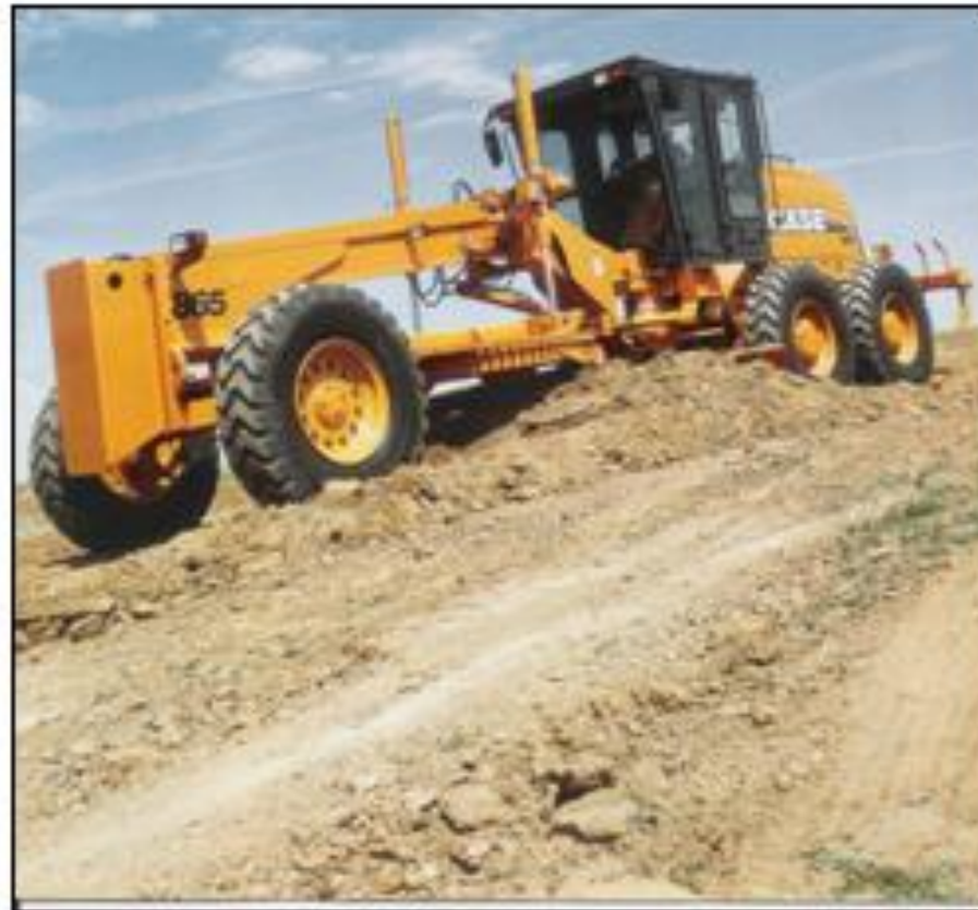
Figura 3.17 Motoniveladora usada para dar el acabado de la capa final
