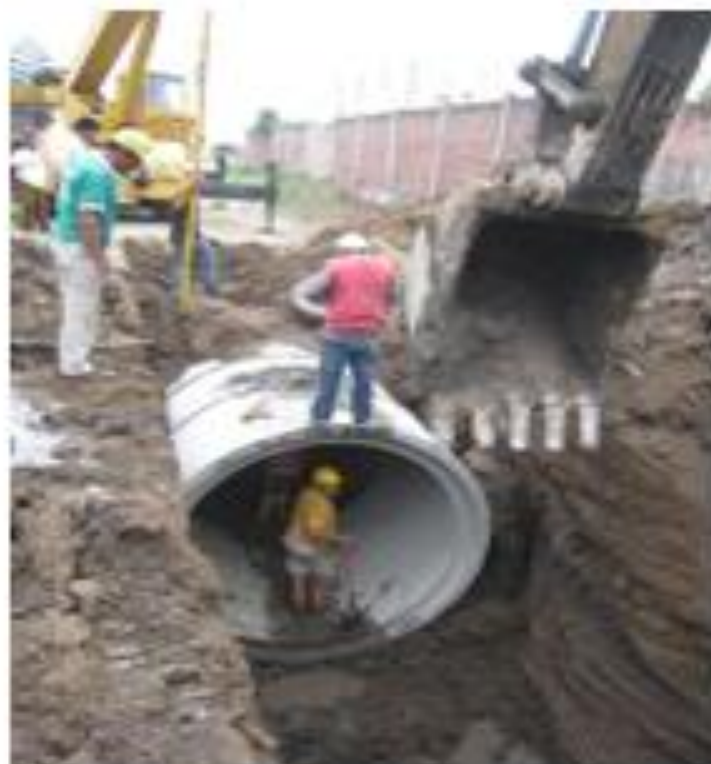
Figura 3.7 Colocación de tubería
