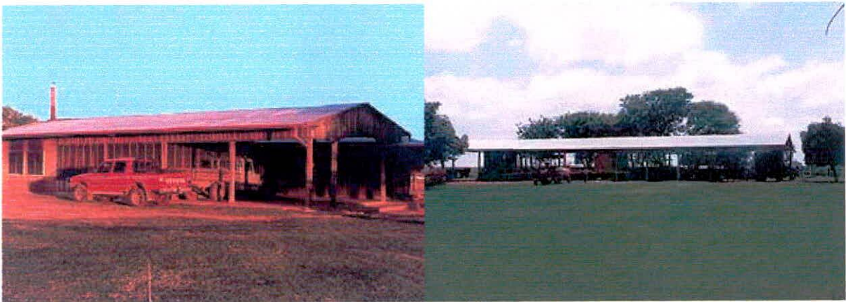
Construcción para cocina, comedor, talleres y garaje
