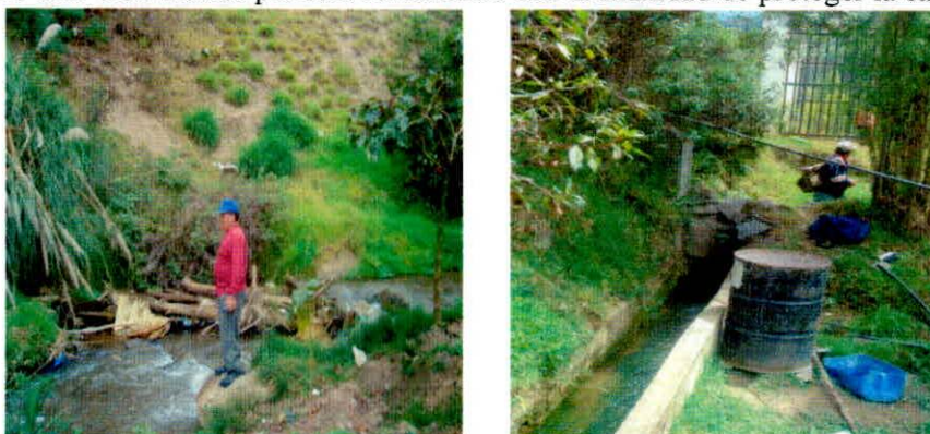
Foto 9: Captación tipo en el río Cutilcay y Canal revestido de hormigón
