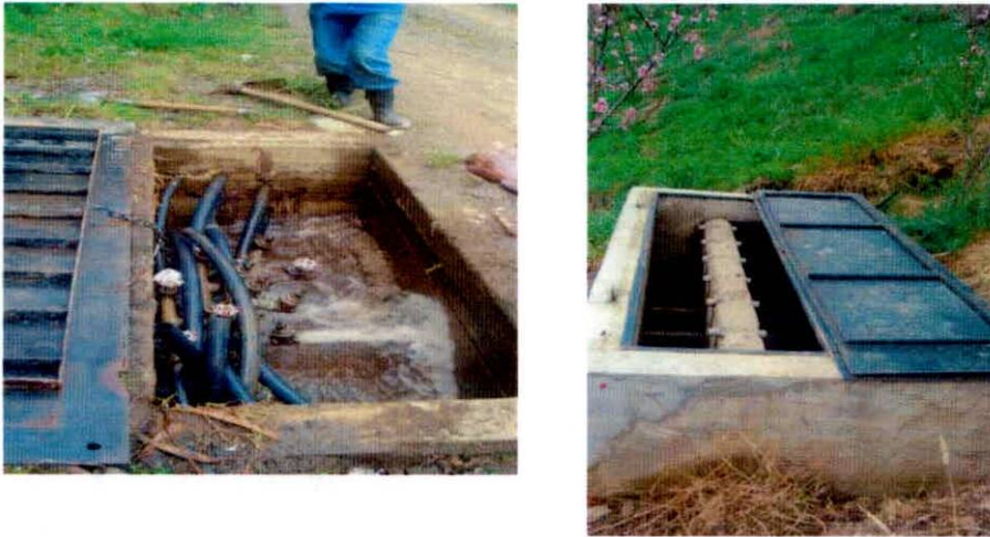
Foto 11: Obras modulares para la distribución del riego.
