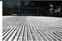
El suelo frigorífico completamente desenrollado
