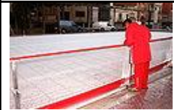
Montaje del vallado perimetral de una pista de hielo temporal
