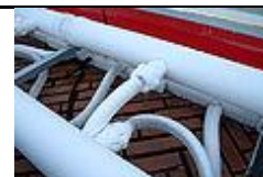
Los colectores principales congelados en una pista de hielo
