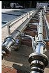
Los colectores principales de una pista de hielo
