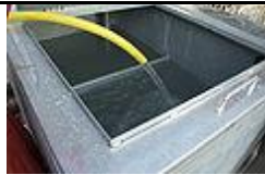
Llenando el buffertank con la mezcla de agua y anti-congelante
