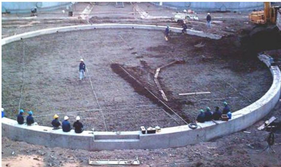
FIGURA 3.3 INSTALACIÓN FINAL DE LA MALLA ANÓDICA EN EL FONDO DEL TANQUE
