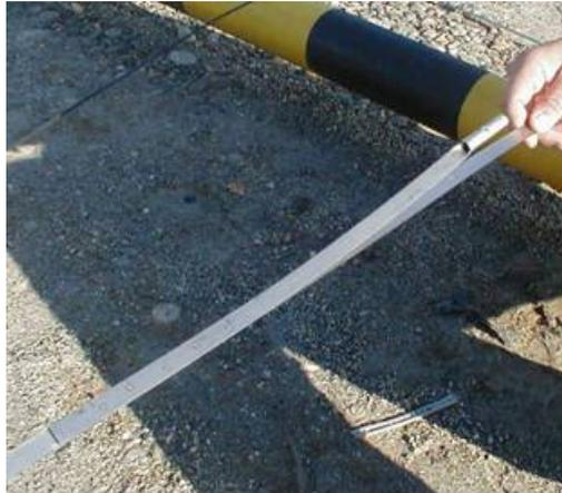
FIGURA 1.3 UNIÓN DE LA PLATINA DE TITANIO CON BARRA CONDUCTORA, MEDIANTE 5 PUNTOS DE SOLDADURA POR RESISTENCIA
