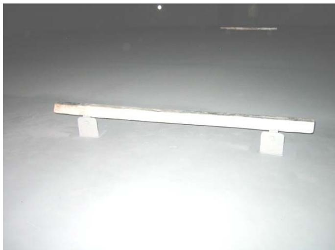
FIGURA 3.4 UBICACION FINAL DE LOS ANODOS GALVALUM III AL INTERIOR DEL TANQUE
