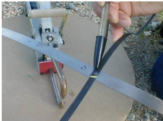
FIGURA 1.4 PUNTO DE SOLDADURA ENTRE BARRA DE TITANIO Y CINTA ANÓDICA UTILIZANDO LA SOLDADORA PORTATIL RSW.
