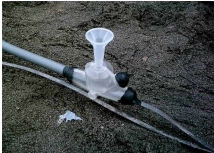
FIGURA 3.2 ENCAPSULACIÓN EPÓXICA EN CONEXIONES ELECTRICAS
