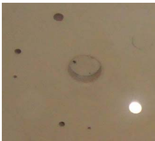
Fuente: Refinería La Libertad, PETROINDUSTRIAL FIGURA 4.7. ACCESORIOS DEL TECHO DEL TANQUE N° 31
