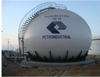
Fuente: Refinería La Libertad, PETROINDUSTRIAL FIGURA 3.1. TANQUE N° 31
