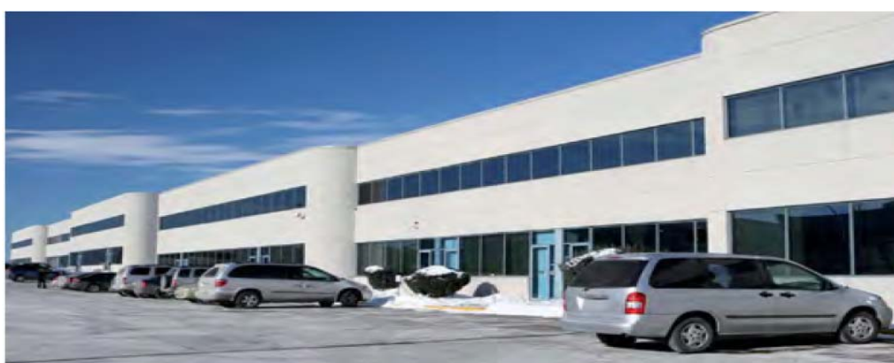
FIGURA 1 - 01: URBANIZACION REDES SUBTERRÁNEAS
