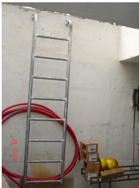
FIGURA 3 - 08: ESCALERAS EN SUBTERRÁNEOS O BÒVEDAS
