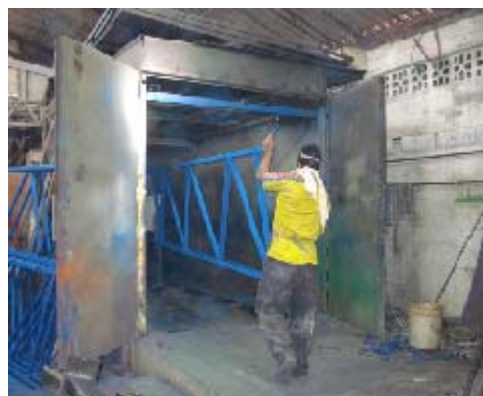
FIGURA 3.10 OPERACIÓN DE TRASLADO AL HORNO
