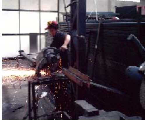
FIGURA 3.12 OPERACIÓN CORTE DE CANALES
