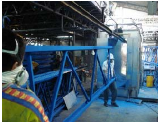
FIGURA 3.9 OPERACIÓN ROCIADO DE PINTURA EN POLVO
