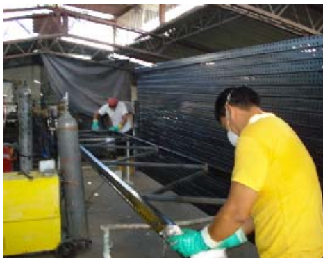
FIGURA 3.8 OPERACIÓN DE LAVADO DE MARCOS
