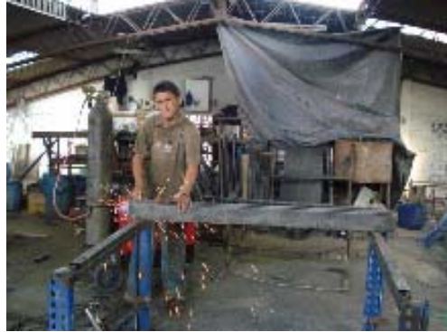
FIGURA 3.14 OPERACIÓN ENSAMBLE DE VIGAS
