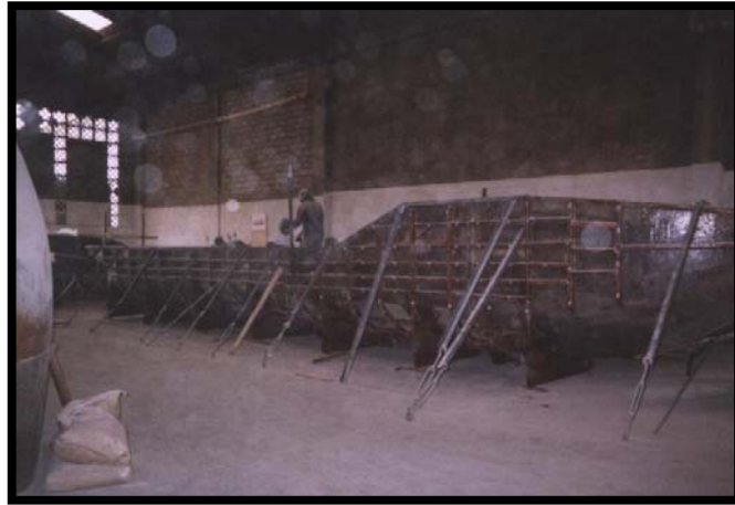
Foto 2.20.- Reforzamiento en molde de casco
