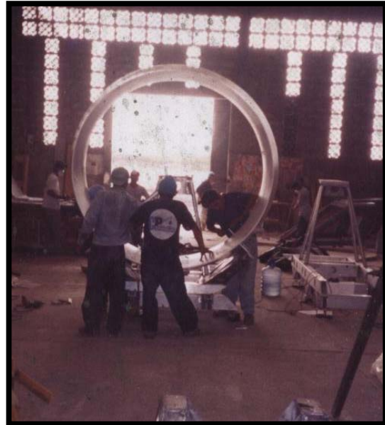
Foto 2.40.- Montaje de tobera de hélice sobre bases de motores de impulsión
