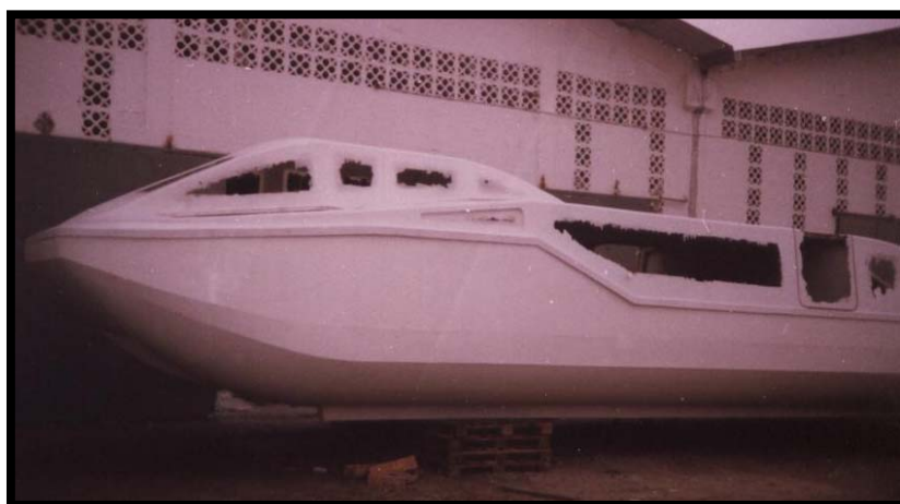
Foto 2.32.- Desmolde de superestructura sobre casco
