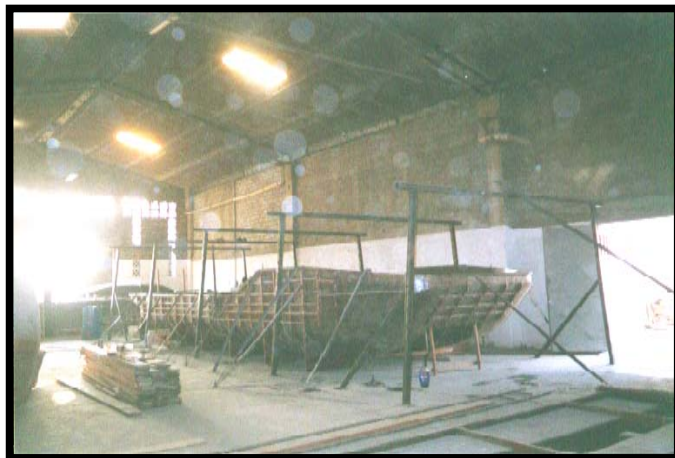
Foto 2.26.- Estructura de Cámara de Laminado
