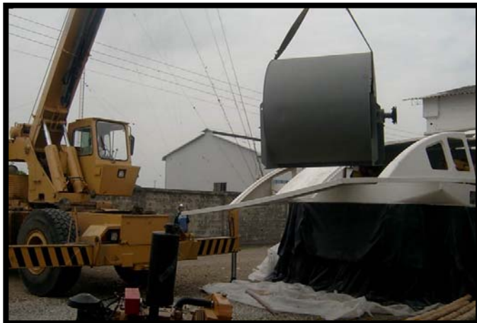
Foto 2.42.- Montaje de soplantes
