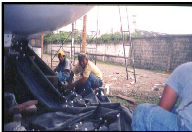
Foto 2.38.- Montaje de estructura flexible
