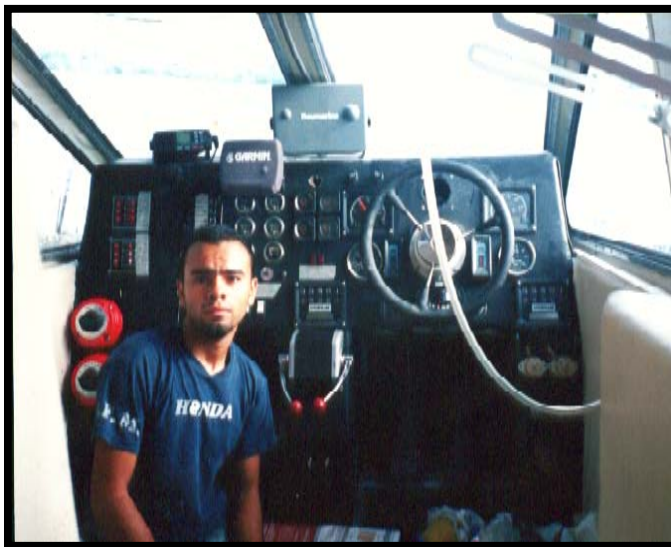
Foto 3.14.- Montaje de panel de control
