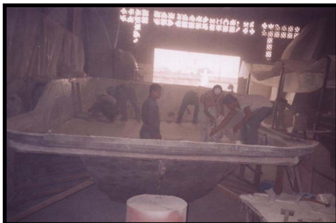
Foto 2.31.- Proceso de laminado para superestructura
