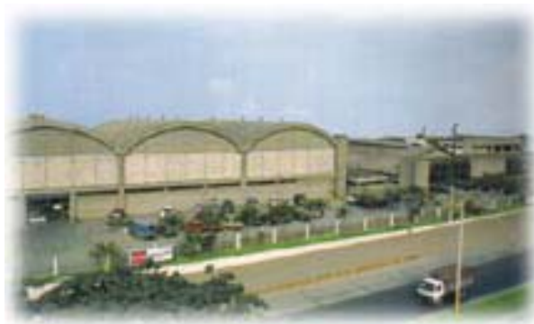
Figura 6.1 Imágenes exteriores de Plásticos del Litoral, PLASTLIT S.A.
