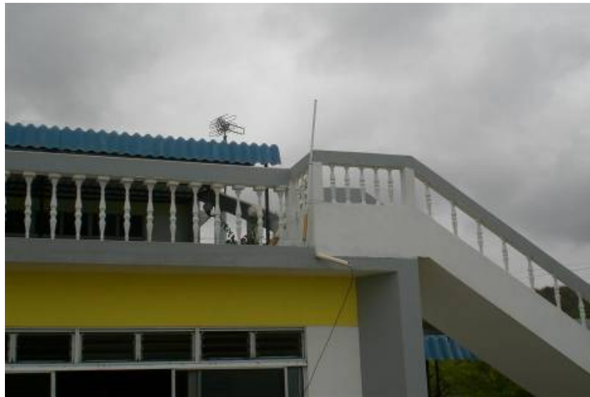
Fig. 5.2. Instalación de la antena en la estación en tierra
