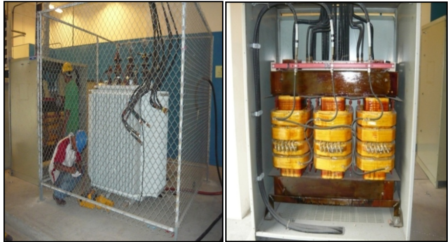
Figura 1.4. Mantenimiento en transformadores S-5 y S-6.
