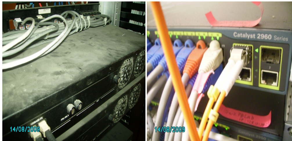
Figura 3.22. Equipos de comunicación Catalyst 2960.
