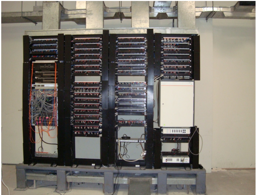
Figura2.15. Central telefónica y de datos.
