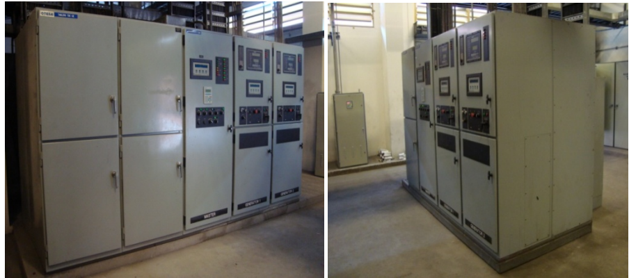
Figura 1.9. Tableros de sincronización del Grupo A y B.
