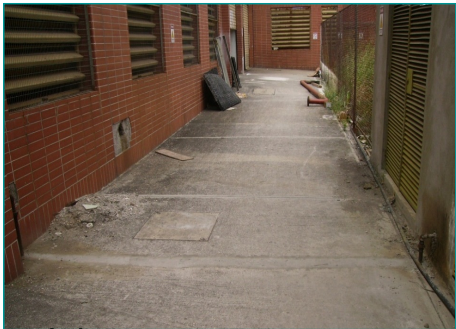
Figura 1.12. Correctivo realizado según norma NEC.
