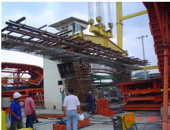
Fotografía 5.2.- Muestra la armadura de un segmento de dovela.
