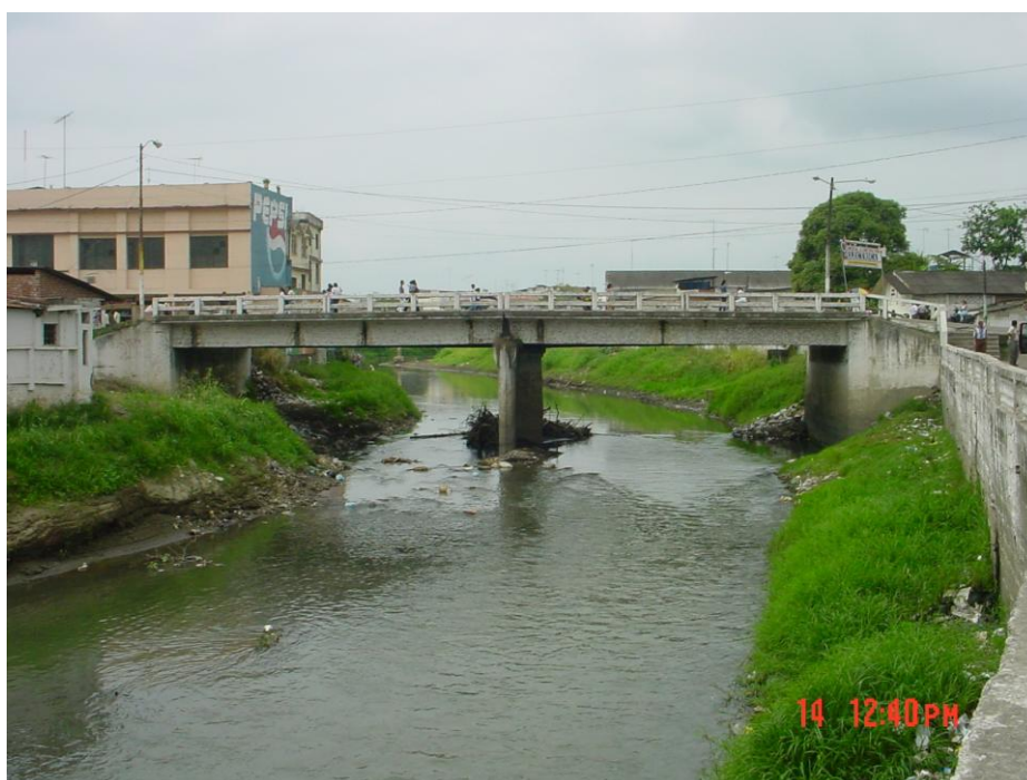
FIGURA 19. PUENTE 17 DE SEPTIEMBRE SOBRE EL RÍO MILAGRO.
