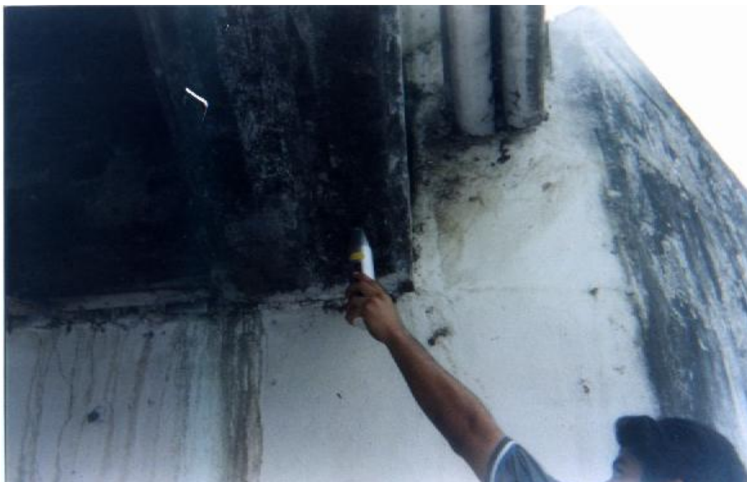
FIGURA 15. ENSAYO ESCLEROMÉTRICO EN VIGAS
