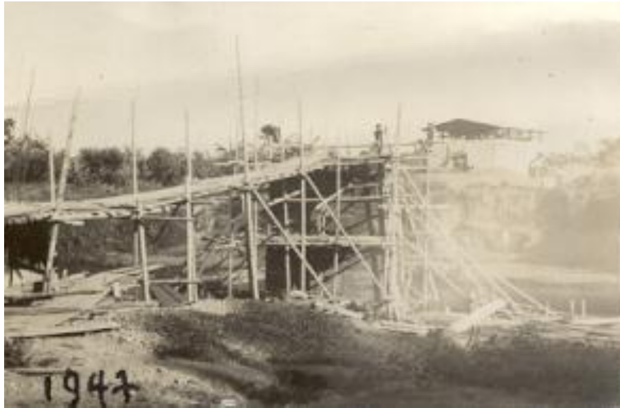
FIGURA 4. INICIOS DE LA CONSTRUCCIÓN DEL PUENTE 17 DE SEPTIEMBRE
