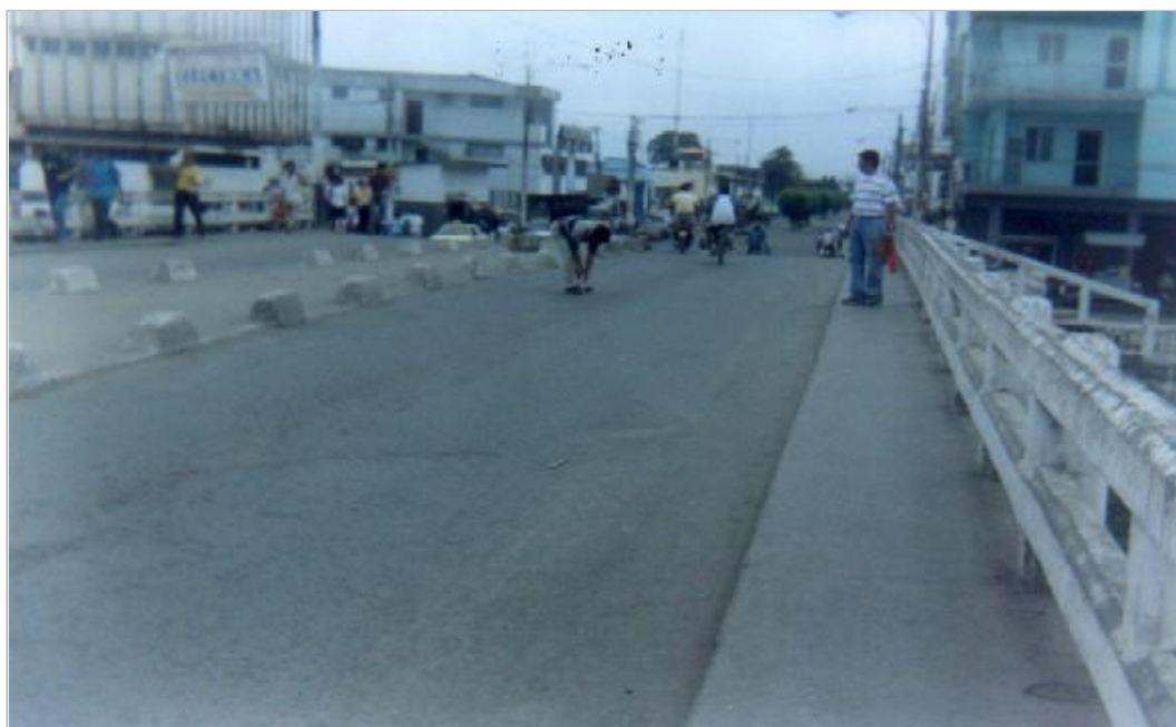
FIGURA 14. TABLERO #2 DEL PUENTE 17 DE SEPTIEMBRE
