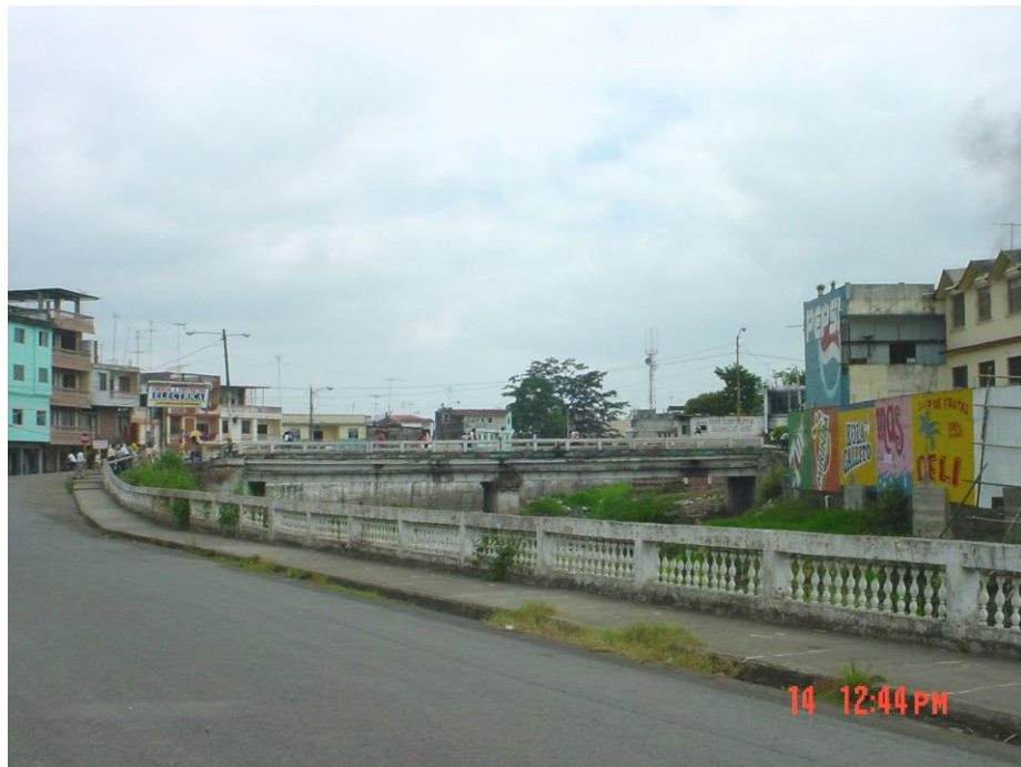
FIGURA 21. MALECÓN JUNTO AL PUENTE 17 DE SEPTIEMBRE
