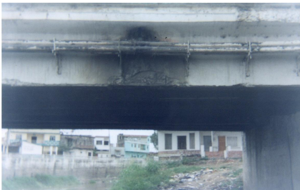
FIGURA 12. VIGA V1 DE TABLERO #1 DEL PUENTE 17 DE SEPTIEMBRE
