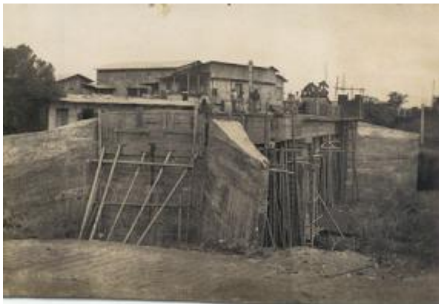
FIGURA 7. VISTA DEL PUENTE 17 DE SEPTIEMBRE DURANTE SU CONSTRUCCIÓN (1947).
