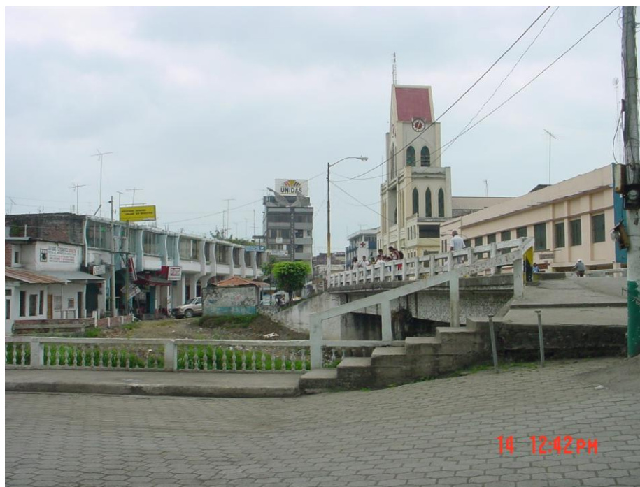
FIGURA 20. ESCALINATA JUNTO AL PUENTE 17 DE SEPTIEMBRE
