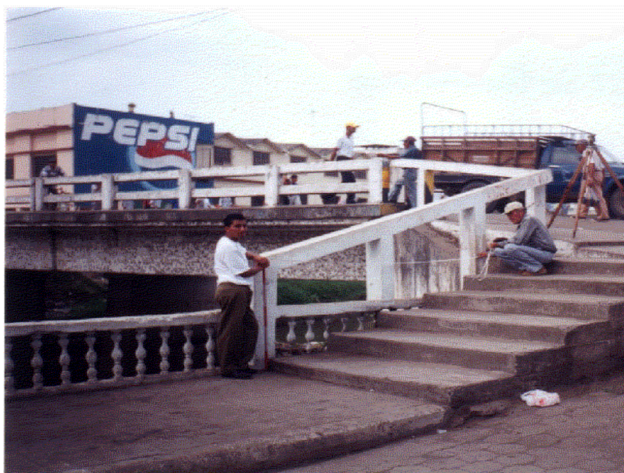
FIGURA 35. VISTA DURANTE EL PROCESO DE EJECUCIÓN DEL LEVANTAMIENTO TOPOGRÁFICO EN EL PUENTE 17 DE SEPTIEMBRE.
