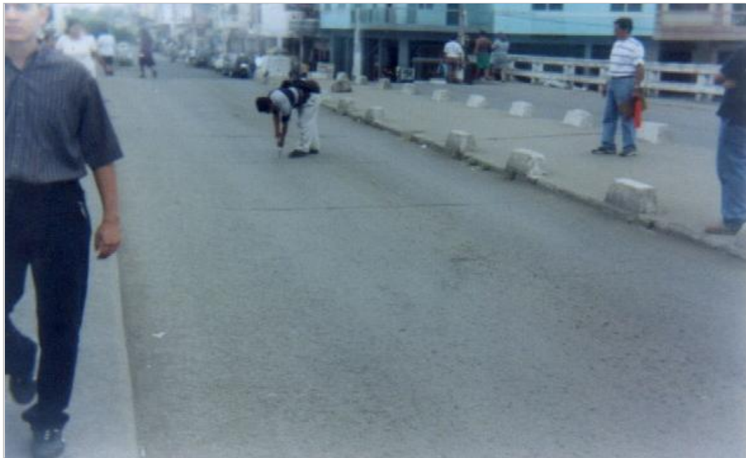
FIGURA 11. TABLERO #1 DEL PUENTE 17 DE SEPTIEMBRE.
