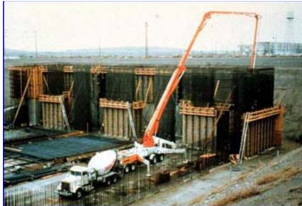
Figura 2.8 Construcción del almacenaje nuclear
