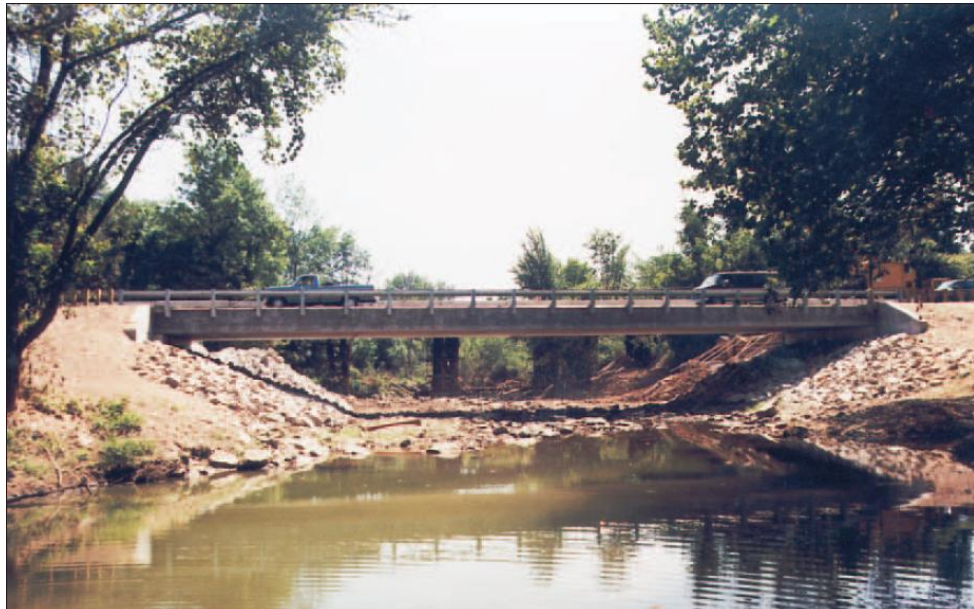
Figura 2.5. Vista del Puente Ohio DOT
