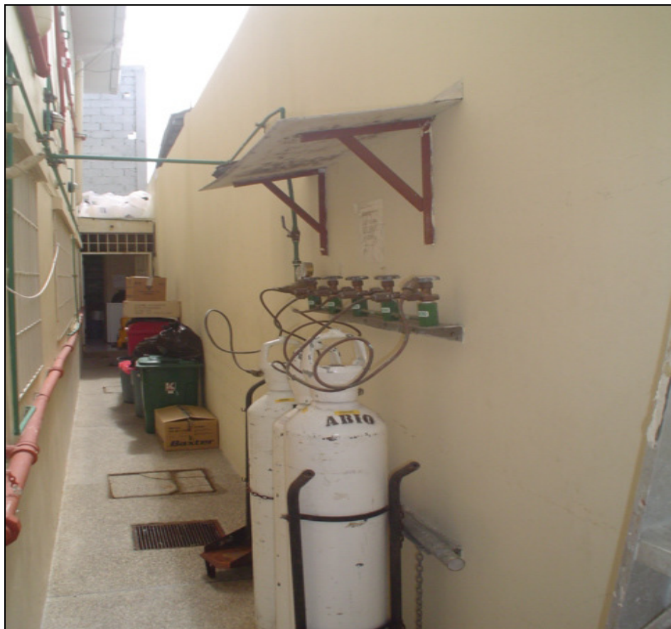
Figura 3.3.1c - Corredor lateral externo derecho (tanques de oxígeno).
