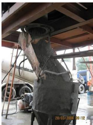
Foto 2.1.3.4 Tolva alimentadora de hormigón
