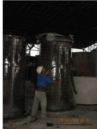
Foto 2.1.3.3 Colocación de la canastilla de acero para ser hormigonada
