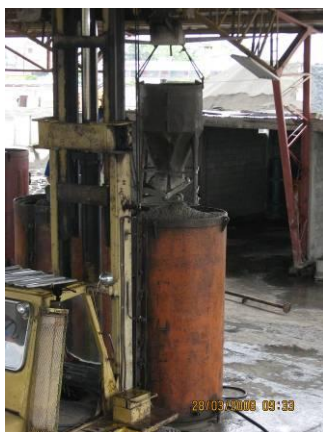
Foto 2.1.3.10 Operación de llenado
