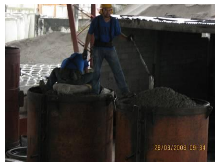
Foto 2.1.3.11 Acomodamiento del hormigón en el molde de la tubería
