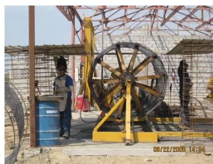
Foto 6.2 Proceso de doblado de la malla
