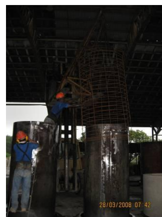
Foto 2.1.3.8 Colocación de la canastilla metálica
