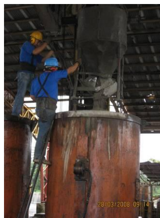
Foto 2.1.3.6 Relleno vertical del molde de la tubería
