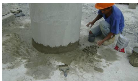
Foto 5.2.3.2 Preparación del mortero hidráulico (Maxiplug)
