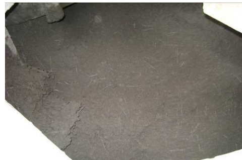
Foto 5.1.5 Mezcla del hormigón con fibra incluida
