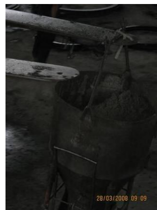
Foto 2.1.3.5 Transportación de la tolva con el hormigón
