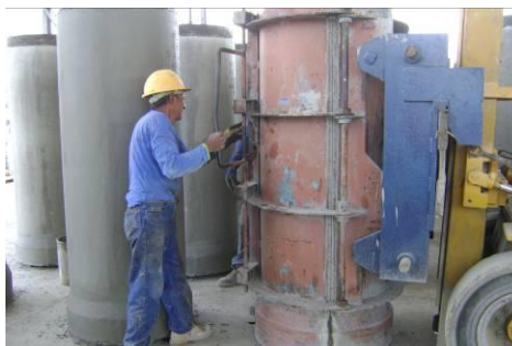
Foto 2.1.3.16 Desmolde de una tubería de 600 mm. de diámetro
