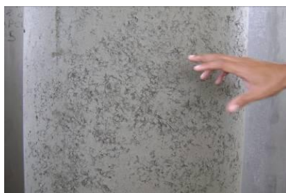
Foto 5.1.11 Aspecto exterior de la tubería de 24" H.R.F.
