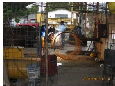
Foto 2.1.3.2 Intervención de soldadores para uniones de las capas de armadura
