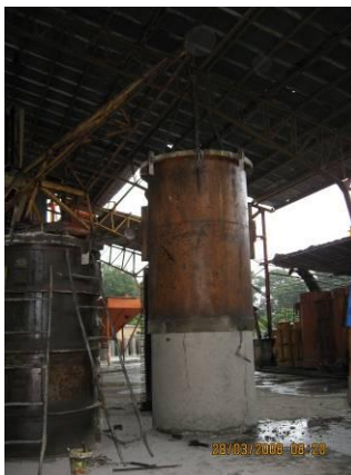
Foto 2.1.3.12 Desmolde de una tubería de 1.000 milímetros
