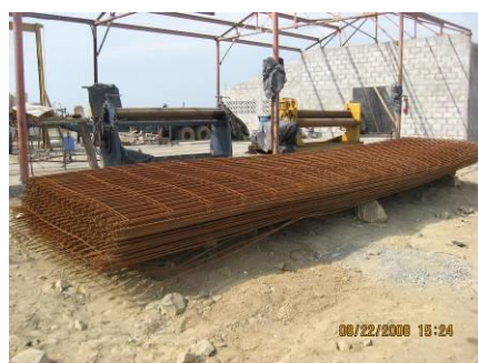
Foto 6.1 Mallas en forma de planchas antes de ser dobladas
