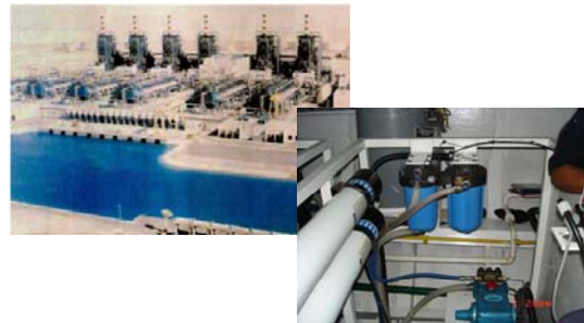
Figura 3. Plantas Desaladoras de Osmosis Inversa y Destilación Súbita Flash
