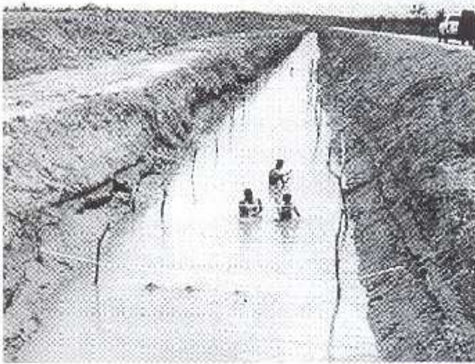
Figura 8. Canal de drenaje
