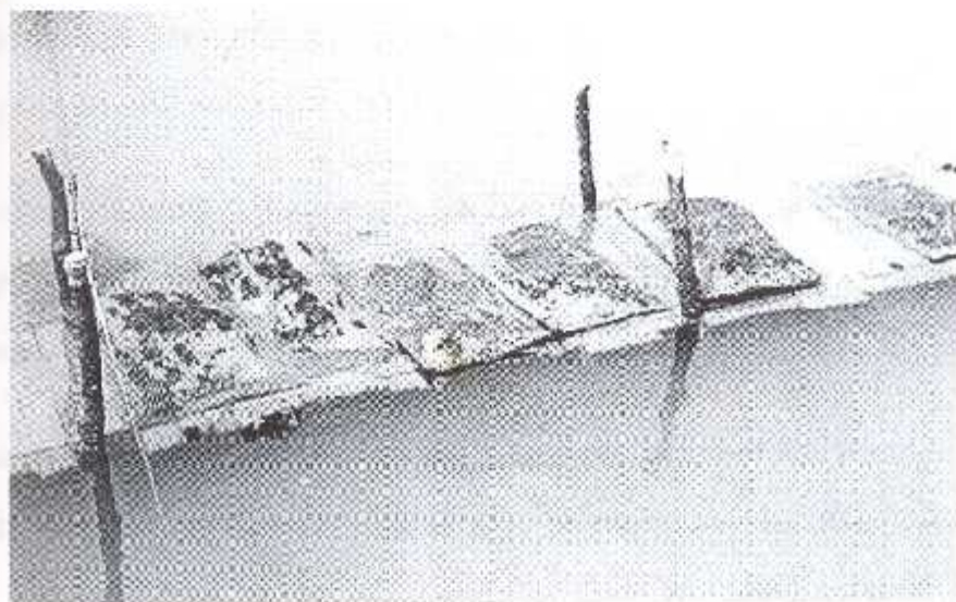
Figura 17. Exceso de sedimento sobre los sistemas
