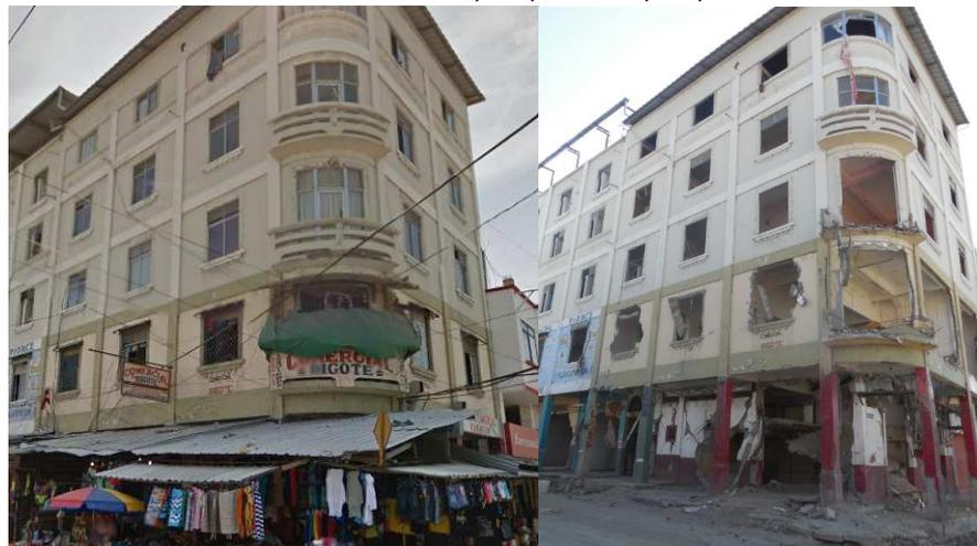
**Figura 5.15** Se observa edificio con daños en mampostería luego del terremoto.
