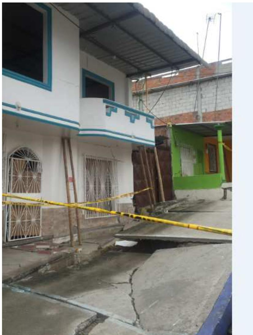
**Figura 5.1** Fotografía mostrando los efectos del fenómeno de licuación causados por el sismo del 16 de Abril.
