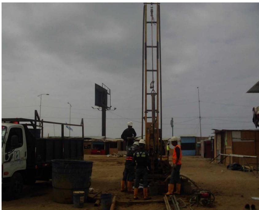
**Figura 2.1** Perforaciones mecánicas realizadas en el campo
