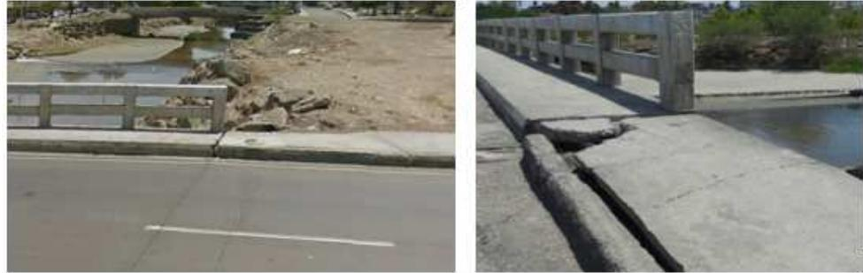
**Figura 5.5** fotografía de inicio del puente que cruza el río Burro, donde se puede observar que no existe daño. (b) Luego del terremoto del 16A2016 se puede observar como se ha deformado la acera.
