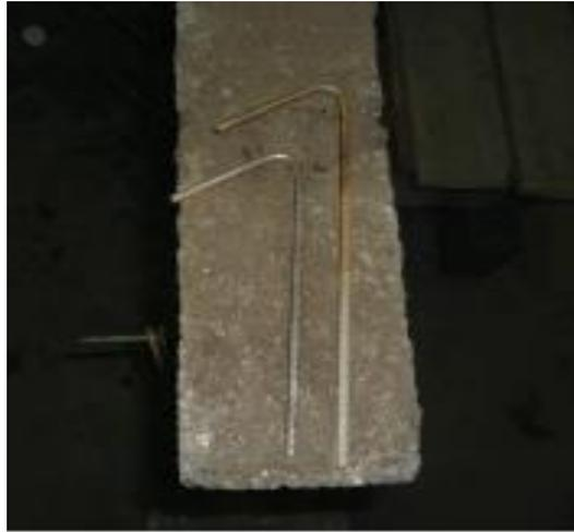
**Figura 11.2** Ganchos de anclaje del bloque del sistema de enchape.
