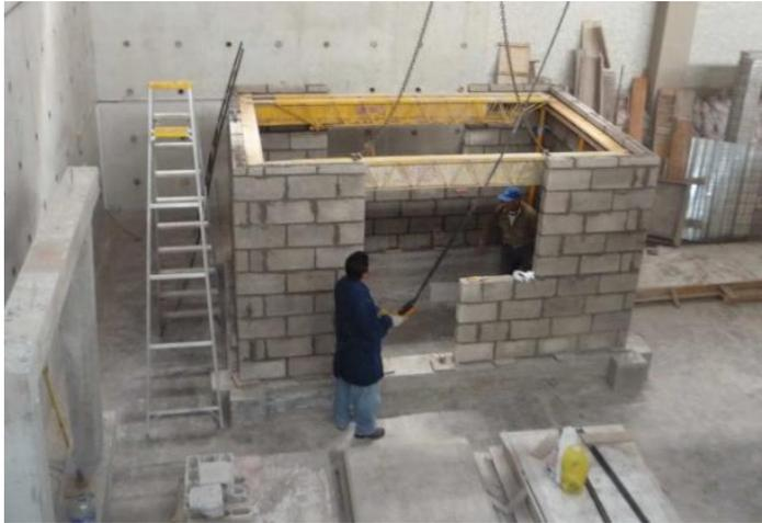
**Figura 11.4** Instalación de vigas y puntales metálicos para fundición de losa.
