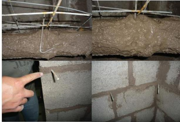
**Figura 11.3** Proceso de colocación de los ganchos de anclaje.
