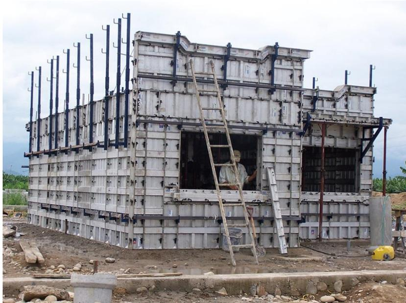
**Figura 11.1** Ecuador, Obras con Forsa Alum, vivienda de 1 piso.
