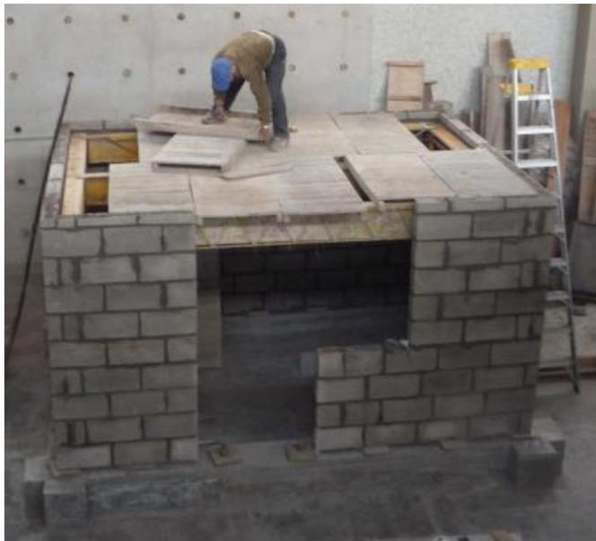
**Figura 11.5** Instalación de tiras de encofrado para fundición de losa.
