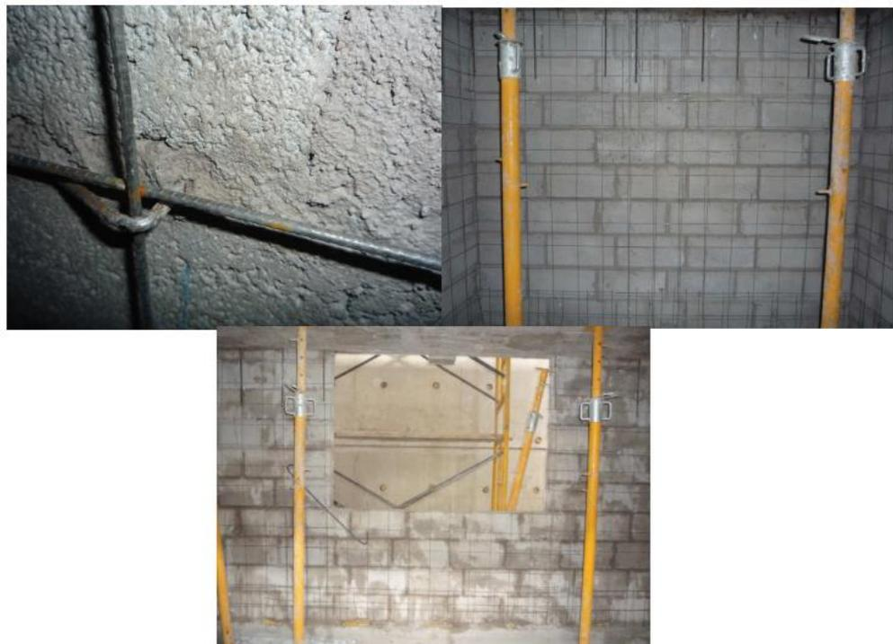
**Figura 11.8** Proceso de colocación de la malla electro soldada.
