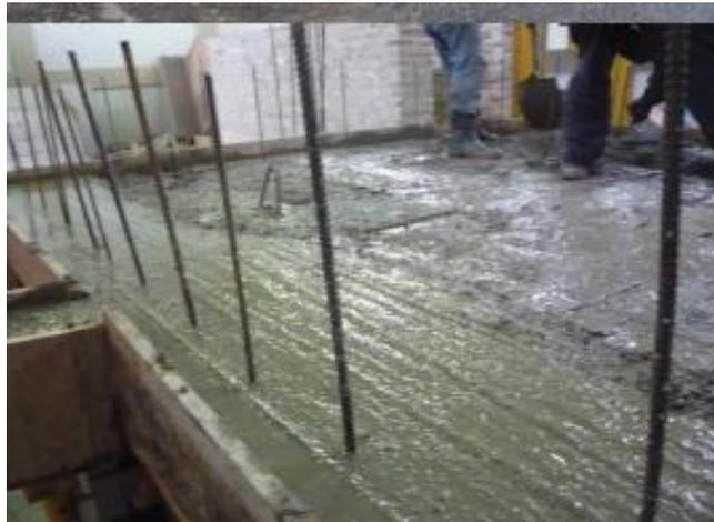
**Figura 11.7** Fundición de losa de primer nivel.
