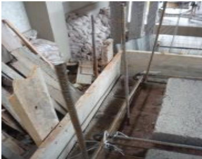
**Figura 11.6** Instalación de chicotes de conexión en armado de la losa para planta alta futura.
