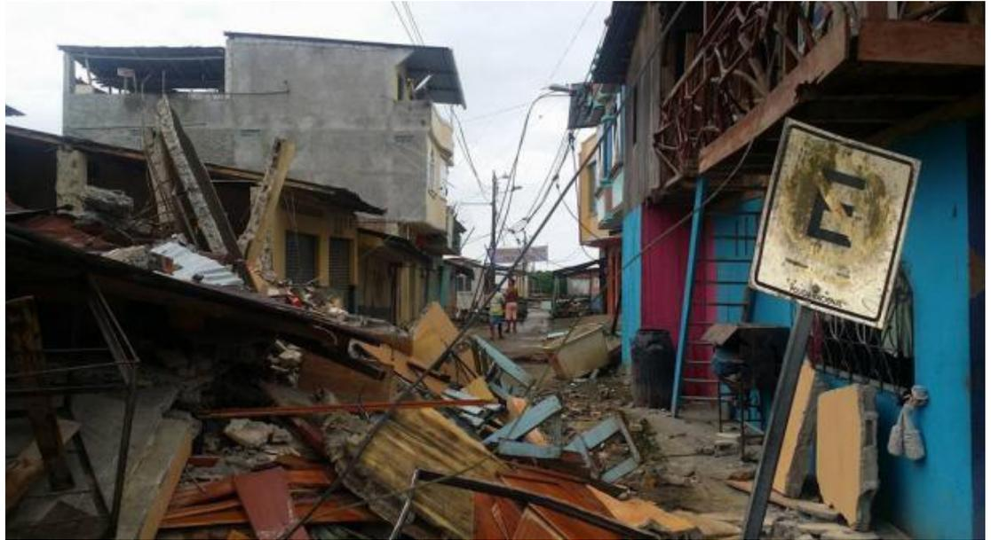
**Figura 3.4** Vivienda colapsada en Muisne a causa del sismo de Pedernales 2016.
