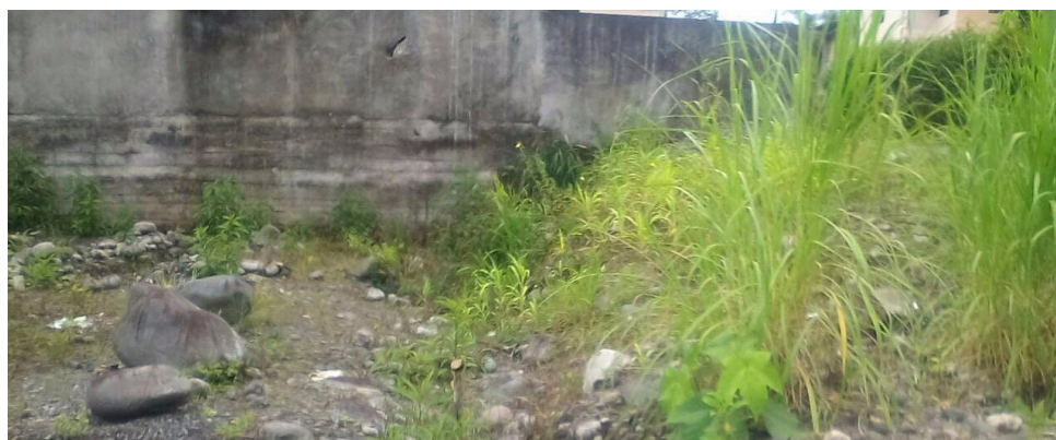
Figura 2.5 Muro de mampostería de la vivienda aledaña. Fuente: Tay Lee, M., Valverde, D., 2017.
