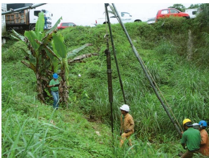
Figura 2.9 Perforaciones en campo. Fuente: Ecuasuelos, 2013.
