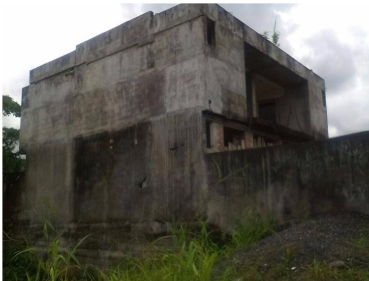
Figura 2.6 Acercamiento del muro de mampostería. Fuente: Tay Lee, M., Valverde, D., 2017.
