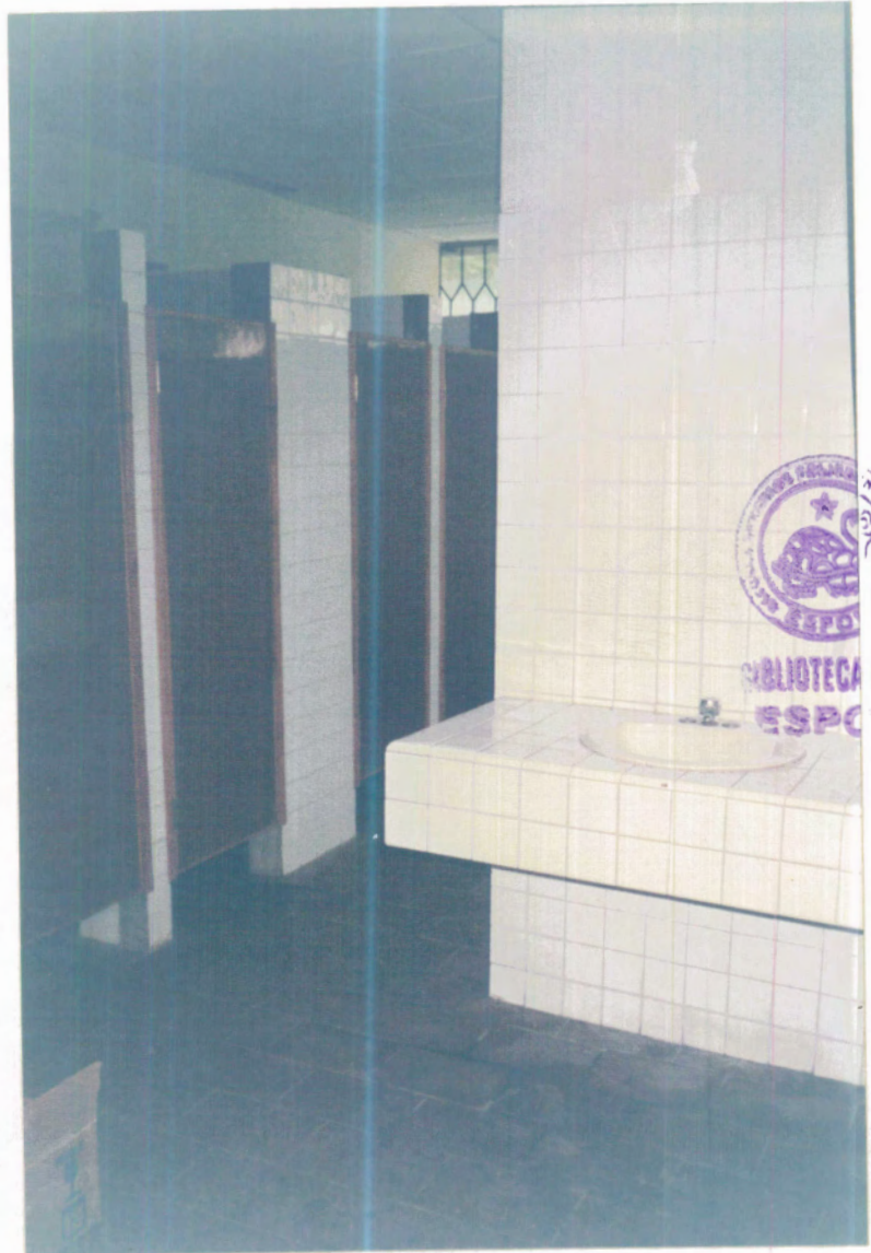
FOTO INTERIOR DE ACABADOS DE BAÑOS # 1
