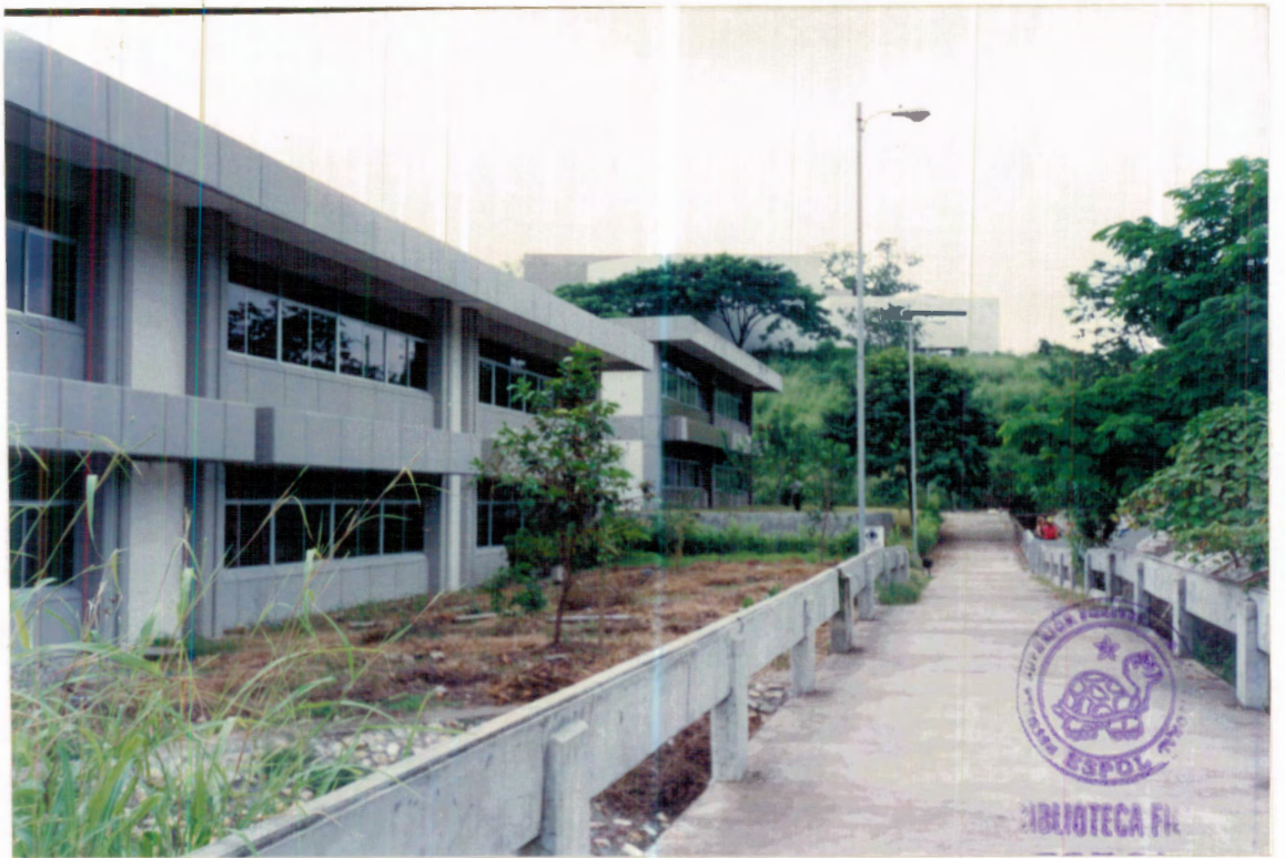
EDIFICIO # 32 A AULAS TEORICAS
