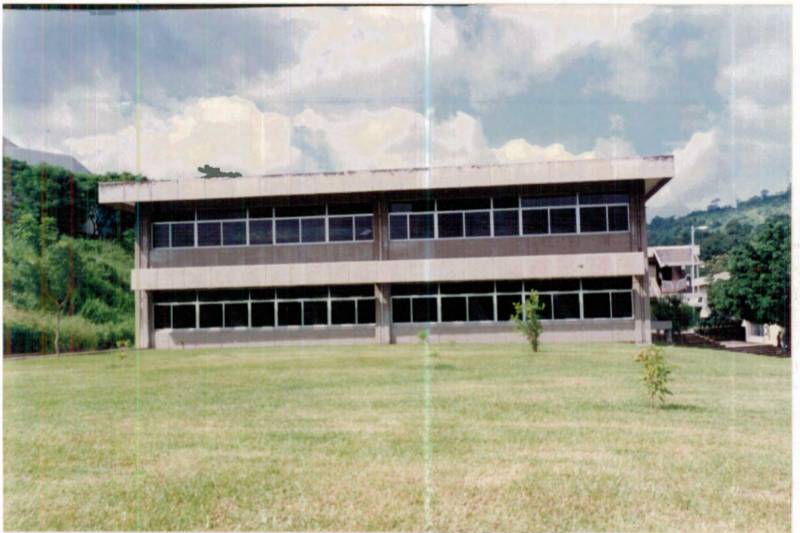
EDIFICIO # 32 B AULAS TEORICAS
