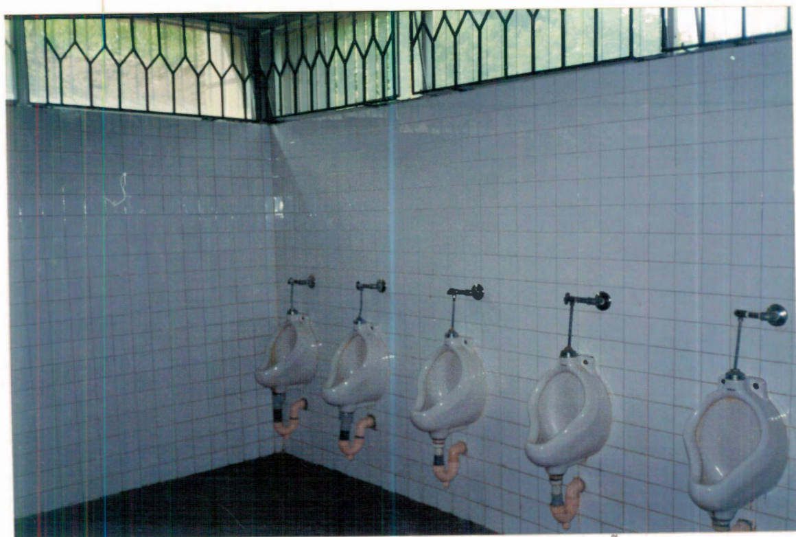
FOTO INTERIOR DE ACABADOS DE BAÑOS # 2
