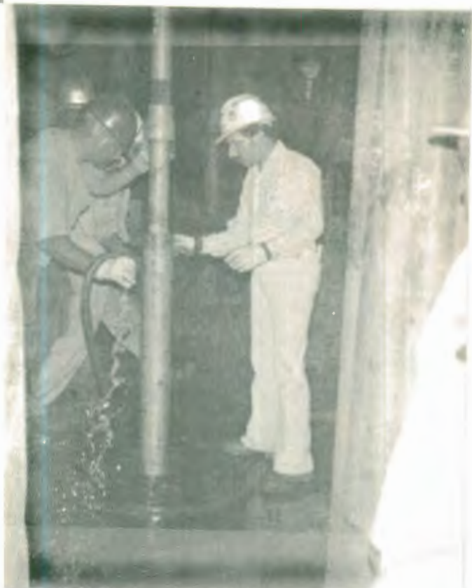
LLENANDO CON AGUA LA EXTENSION DEL RECEPTACULO PULIDO.
