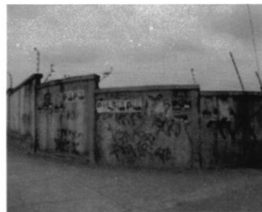
Fig.6 Vista frontal de las últimas paredes
