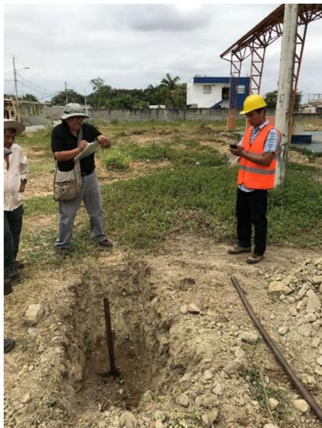
**Figura 3.2** Calicata de perforación 1.
