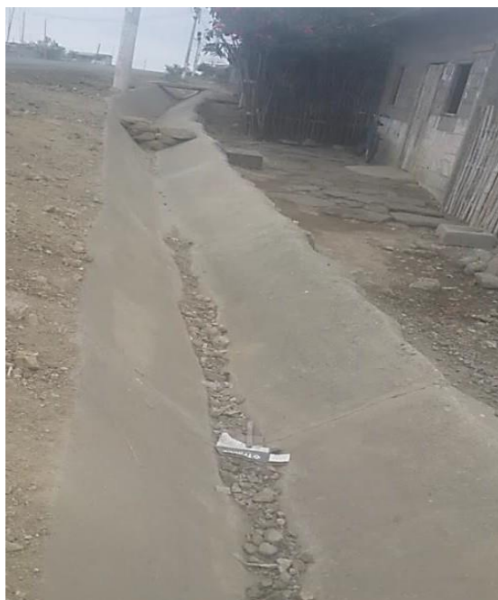
Figura 2.8 Canal de conducción de aguas lluvias hacia alcantarillado.
