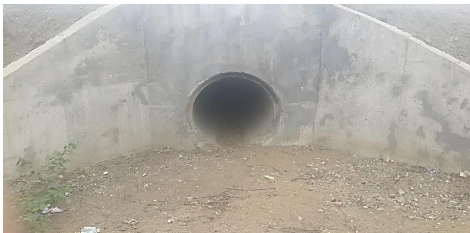
Figura 2.7 Alcantarilla en la carretera para drenaje de aguas lluvias Fuente: Loor, C., Melendres, J., 2016.
