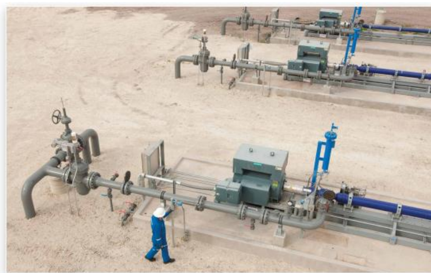
Figura 2. 17 Sistema de Bombeo Hidráulico con H.P.S. Fuente: folleto de SLB-Sistema de Bombeo Superficial Horizontal de etapas múltiples REDA HPS G3.
