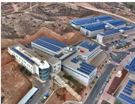
Figura 3.1 Paneles fotovoltaicos en la universidad [41]
