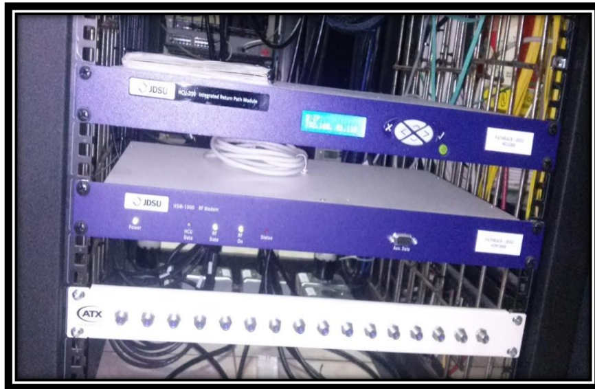
Figura 4. 17. Equipo HCU-200 (PathTrak Return Path), se encarga de la medición de recibo.
