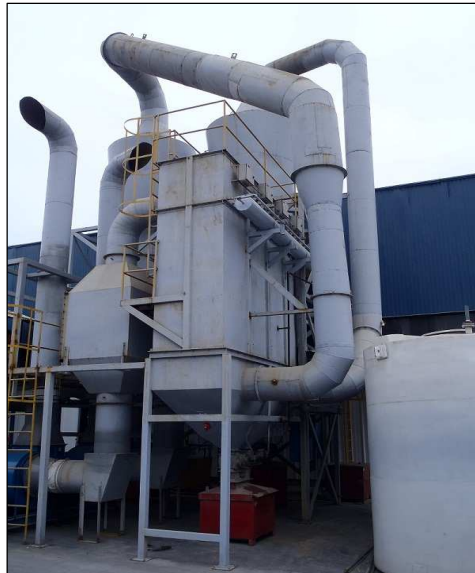
FIGURA 4.2 FILTRO DE MANGAS DE LA FÁBRICA DE BATERÍAS
