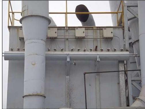
FIGURA 4.3 SISTEMA DE LIMPIEZA DEL FILTRO DE MANGAS
